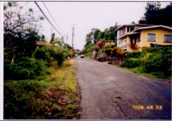
写真 60 (STA:18+700) 道路幅員 6.0m
