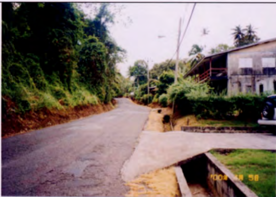
写真 61 (STA:19+700) 道路封印 6.5m 取り付け入り口の状況
