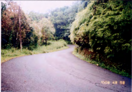
写真 29 (STA:9+800) Sカーブ区間 道路幅員 5.5m
