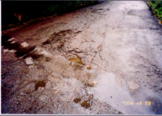
写真 17 (STA:5+500) 舗装の補修状況
