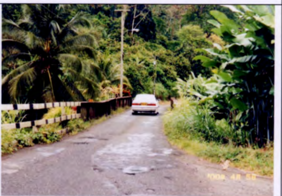
写真 48 (STA:16+000) Balthzar Bridge 幅員 4.0m、橋長 30m
