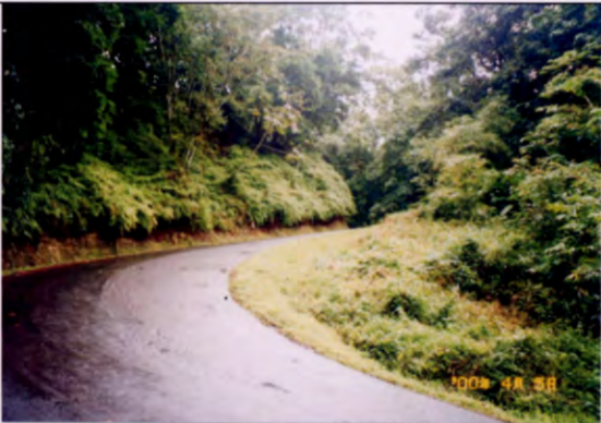
写真 23 (STA:6+550) 見通しの悪いカーブ区間
