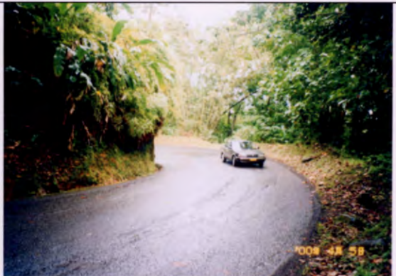
写真 24 (STA:7+300) 切土法面の自然植生 道路幅員 6.0m
