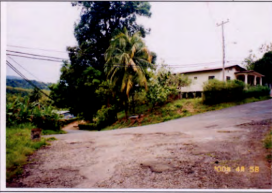
写真 58 (STA:18+500) ヘアーピンカーブ区間 見通しが悪い
