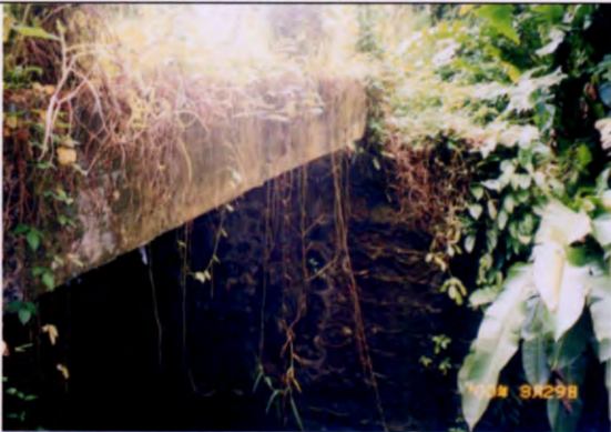
写真 21 (STA:6+000) 新設ボックスカルバート
