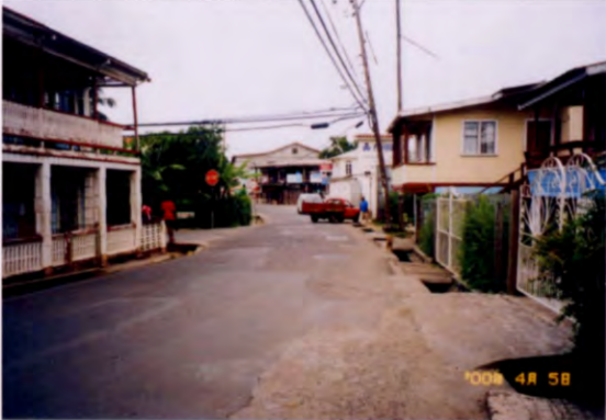
写真 63 (STA:20+200) 沿道に商業施設立地
