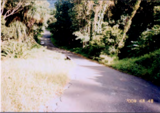
写真 19 (STA:5+900) Vendomme Bridge 幅員 4.0m、橋長 4.0m、ボックスカルバート
