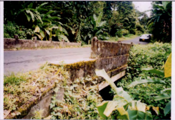
写真 32 (STA:10+800) St. Margaret Bridge ホックスカルパートタイプ
