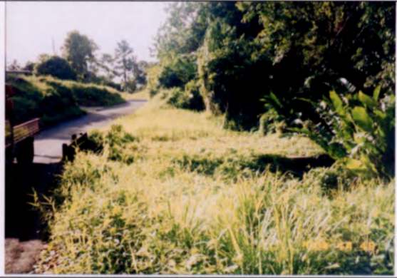
写真 20 (STA:6+000) 新設ボックスカルバート整備済 幅員 8.5m
