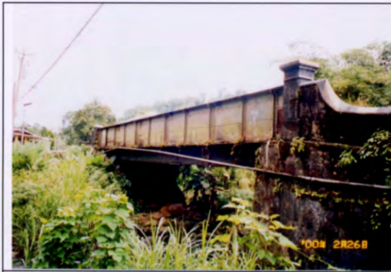
写真 41 (STA:12+920) Birch Grove Bridge 橋梁タイプ：下路鋼盤桁橋
