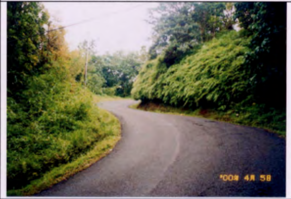
写真 28 (STA:9+700) 見通しの悪いカーブ区間 道路幅員 5.0m
