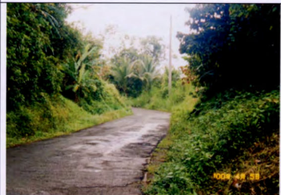
写真 47 (STA:15+050) 見通しの悪いカーブ区間 道路幅員 5.5m
