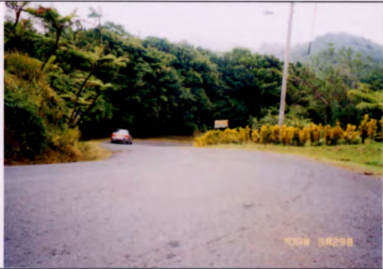
写真 27 (STA:8+650) Sカーブ、道路勾配 6% 道路幅員は 7.0m 広い
