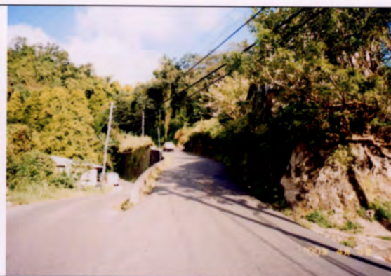
写真9 (STA:3+800) 道路幅員 4.5m 延長約 1400m に渡って続く
