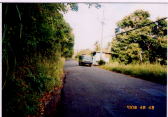
写真8 (STA:3+000) 道路幅員 4.5m と狭く、 車の交差が困難
