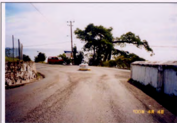
写真1 (STA:-1-400) 起点、Melville/River Road Roundabout
