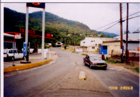
写真5 (STA:0+000) Tempe/Mt. Gay Roundabout
