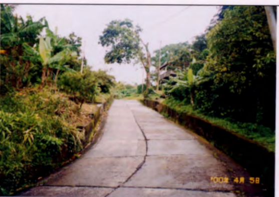
写真15 (STA:5+200) コンクリート舗装 道路勾配 14%
