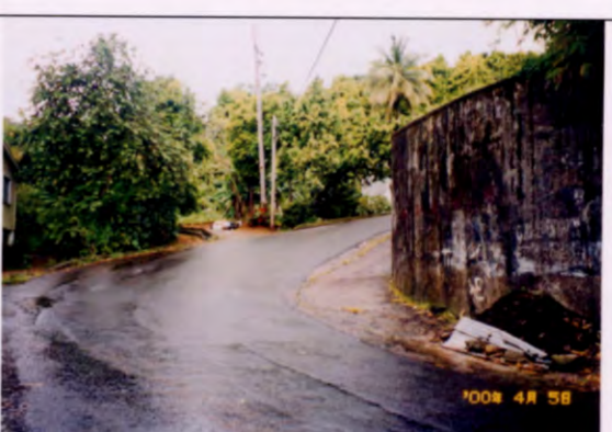
写真14 (STA:5+055) 工事済の切土法面
