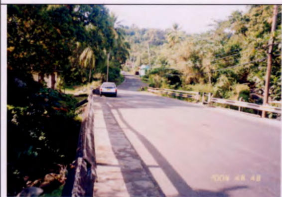
写真7 (STA:1+200) Bealuieu Bridge 幅員 7.0m, 橋長 20.0m
