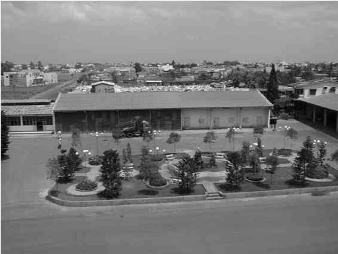
図 - 4 排水処理設備建設予定地
