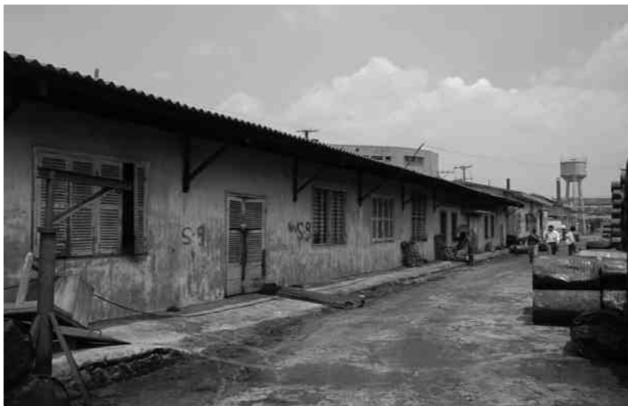
図 - 6 排水処理設備設置予定地
