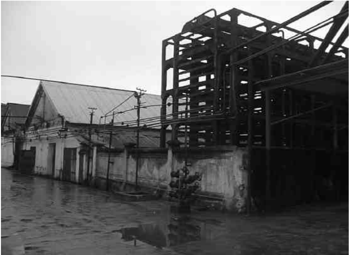
図 - 5 排水処理設備設置予定地
