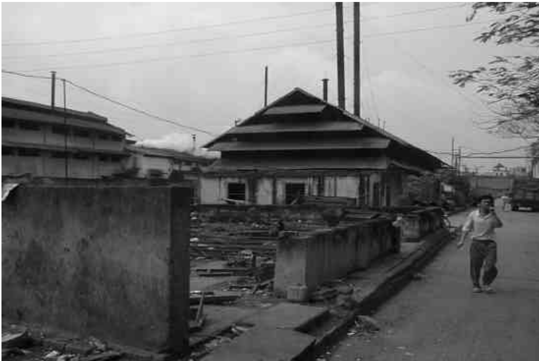
図 - 5 排水処理設備建設予定地
