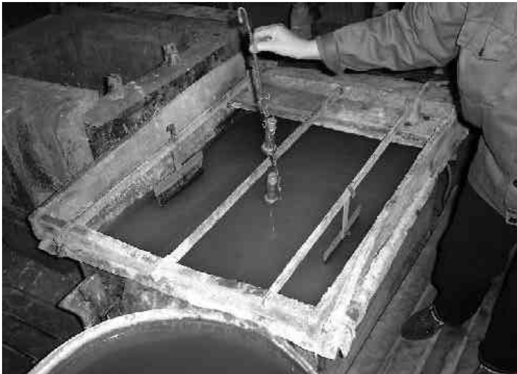
メッキ工場 / 亜鉛メッキ槽
