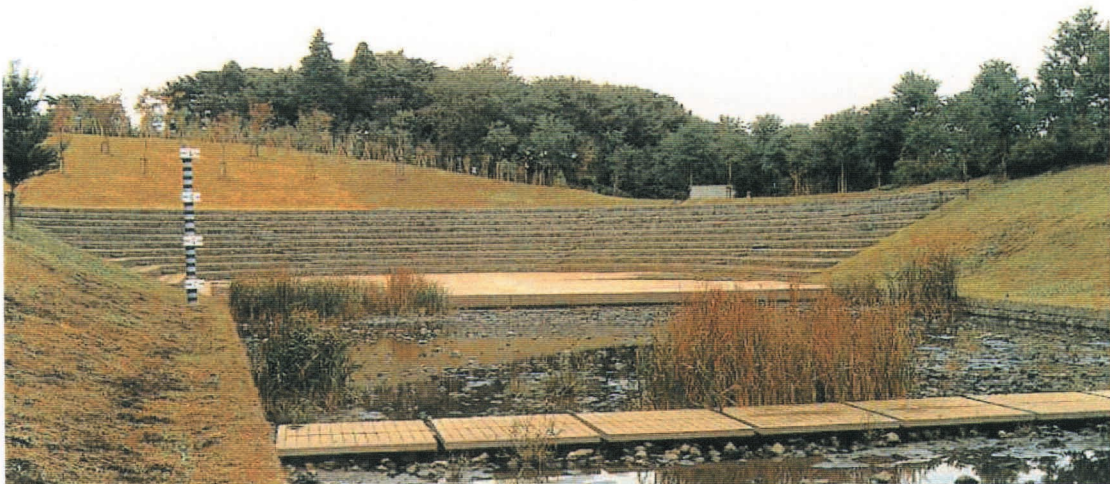
Keio Univ.-A Detention Pond
