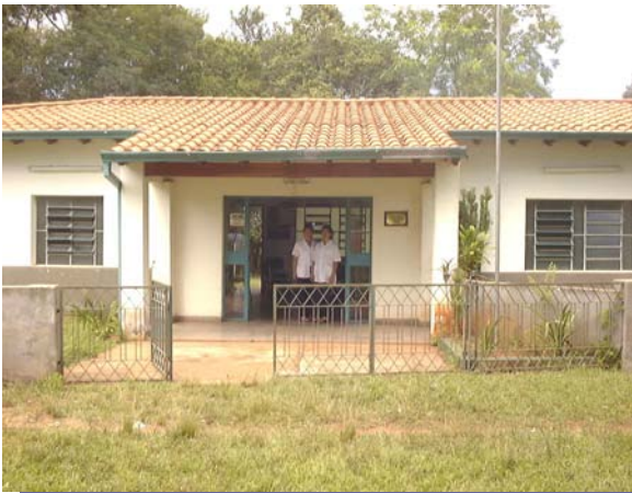
プロジェクトにより建設された地域の保健ポスト
