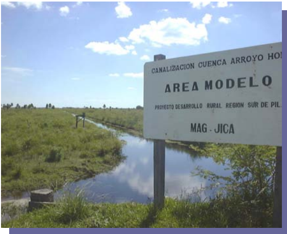
プロジェクトで建設された排水路
