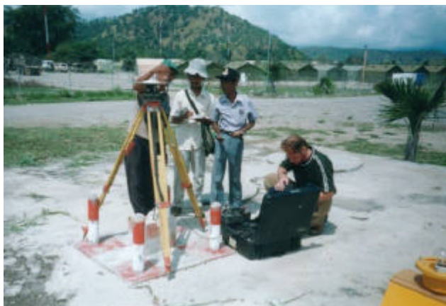
Comoro 空港の管制塔の前 における GPS 観測 (平面座標の与点)
