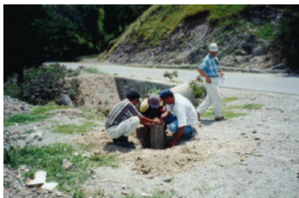
コンクリート杭の建設 ( JICA-2 点 )
