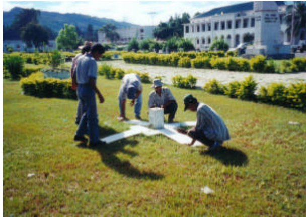
UNTAET の中央事務所に前 における対空標識の設置 (TTG-0157 点)
