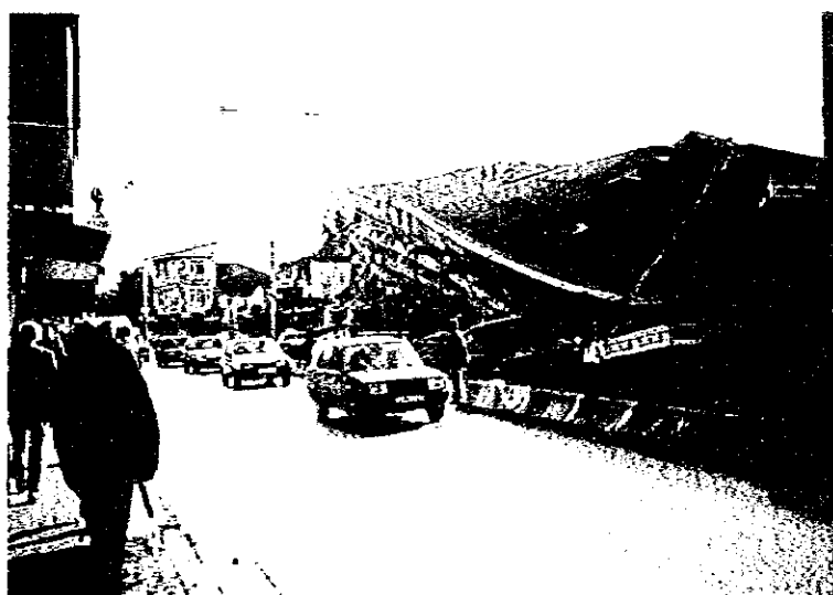
写真2 ドゥズジェ被災状況（2）
