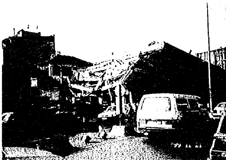
写真1 ドゥズジェ被災状況（1）
