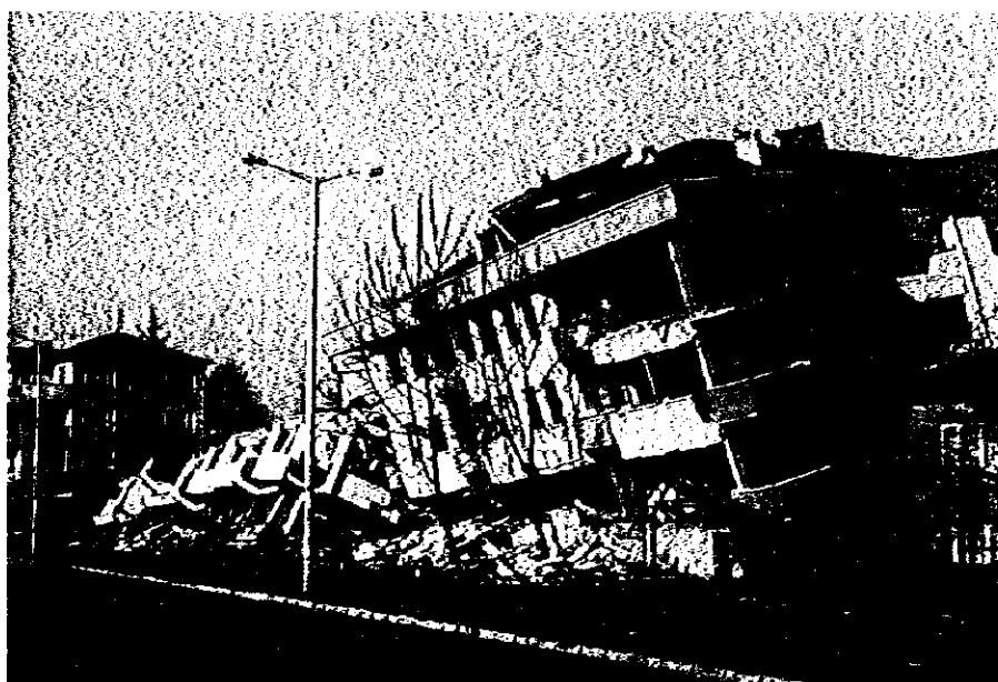
写真3 ドゥズジェ被災状況（3）
