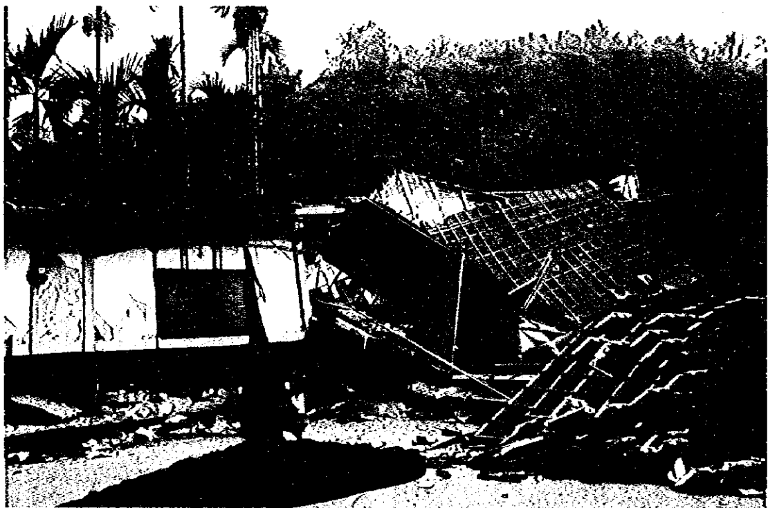
鹿谷の被害状況
