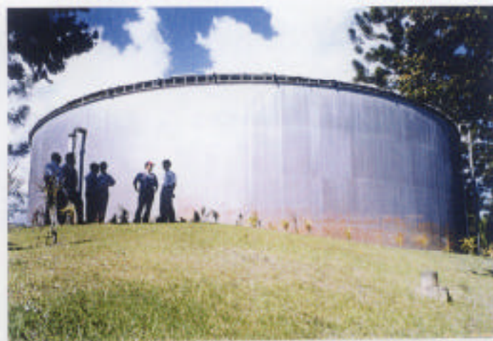
(21) 既存配水池（現在 2 基あり、貯水量は各々、 2,300\text{m}^3 、 4,600\text{m}^3 となっている。写真は 4,600\text{m}^3 。）
