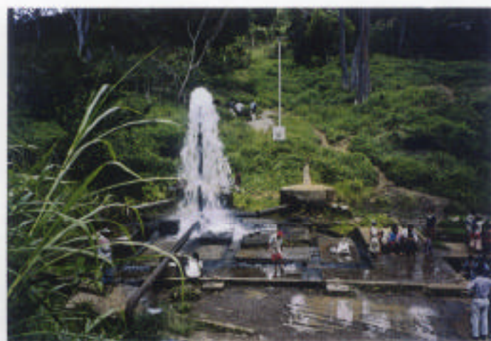
(15) 既存導水管（旧発電施設の水圧鉄管路を使用しており、この地点で圧力調整している。現在、付近住民の憩いの場となっている。）
