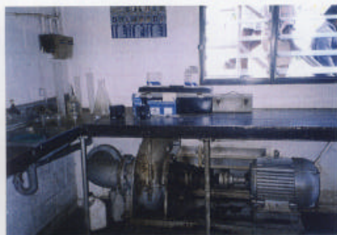
(19) 既存浄水場内水質検査室（浄水場内ではpHのみ検査しており、凝集材注入量は目視にて濁度を確認し決定している。）
