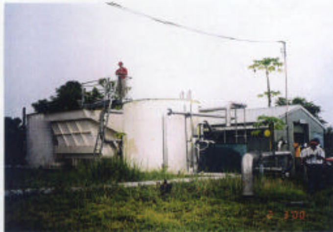
(4) 既存浄水場（Waterboardの予算にて1995年に 建設されたが、その後、配水管の漏水過多の理由 により運転されていない。）
