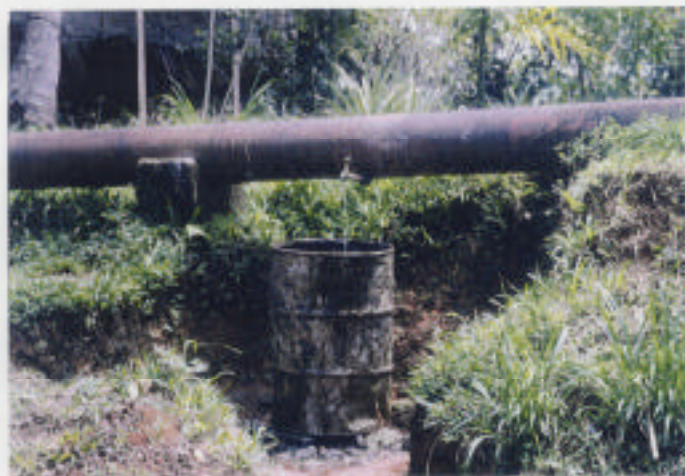
(7) 既存配水本管（地域住民が本管に給水栓を直接接続し、利用している。）
