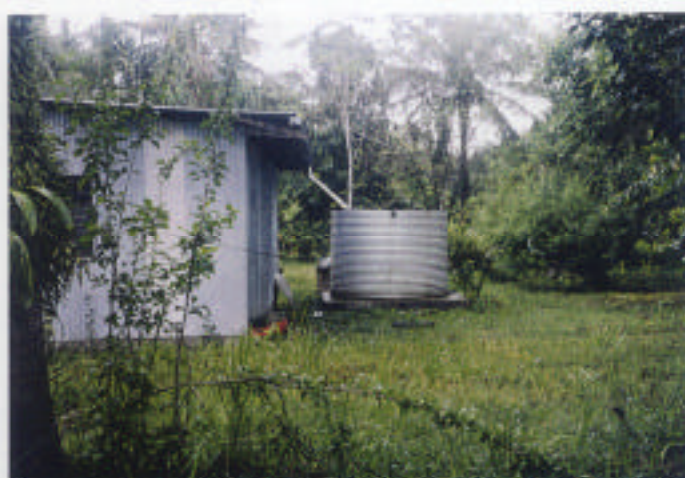
(9) 天水貯水施設（地域住民の多くが各世帯で設置し、飲料水として利用している。）
