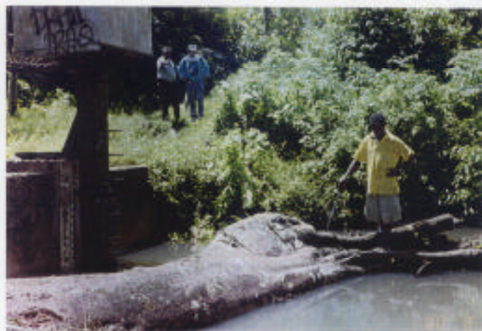
(2) 既存取水施設（1940～50年代に建設され、老朽 化が著しい。）
