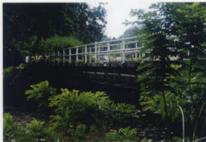
(8) 既存配水本管（橋梁添架部分。新設橋梁が建設中であり、将来的に配水管も付け替えする必要がある。）
