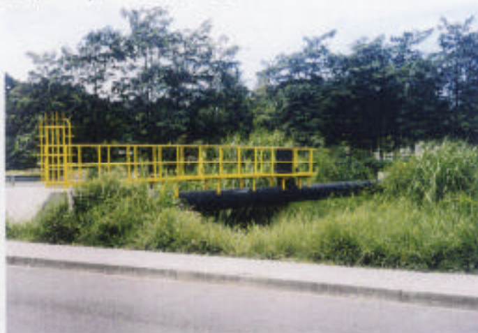
(27) 本邦の無償資金協力により 1994 に建設された送水管管路 (水管橋)
