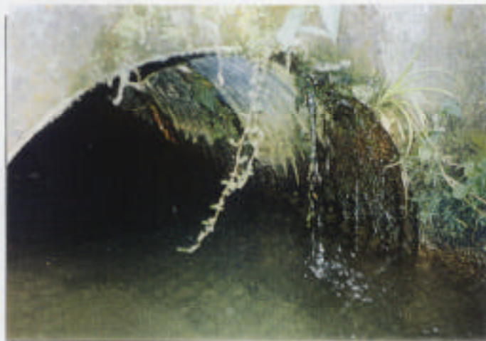
(13) 既存導水路暗渠部（半割コルゲート管を使用している。）
