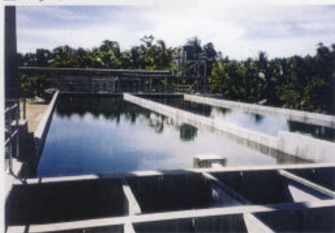
(23) マダン浄水場 (ADB 融資により 2000 年 3 月に完成した。)
