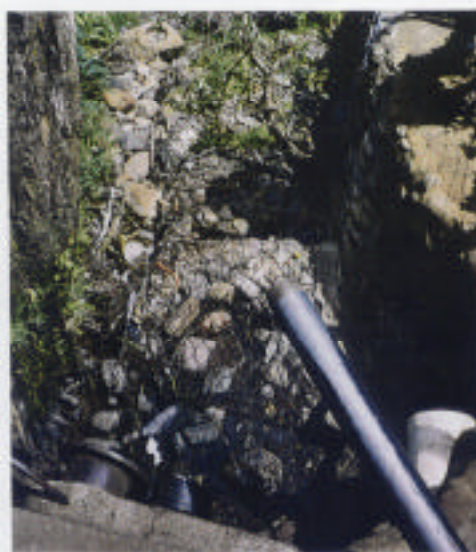
(20) 汚泥放流先（地域住民が放流先の小川を利用している。）
