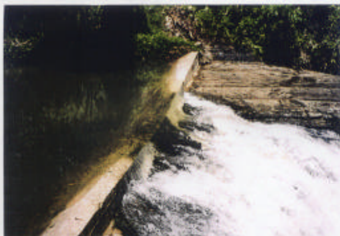
(1) ローレンガウ川既存取水堰（過去、2000年水需 要量を下回る流量が観測されている。）
