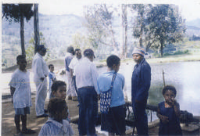
(14) 既存導水路末端調整池（調整池内に堆砂が確認される。）
