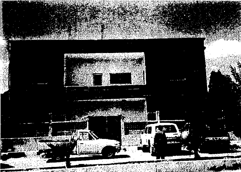
工事完了後、主要施設の運転・維持管理を行うダマスカス郊外県上下水道公団カタナ水道事務所正面入り口。
