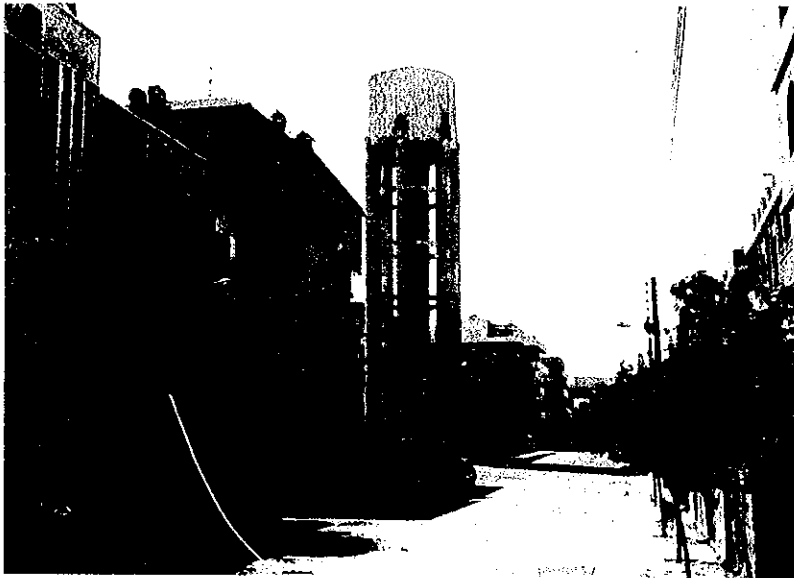
アシュラフィアの住宅地内にある高架水槽。 ダラヤと同じく高さ約 30m、容量 300m 3 。
