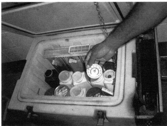
ゴロカ近郊のヘルスセンターにある電気&ガス冷蔵庫。通常、電気にて稼働している。
