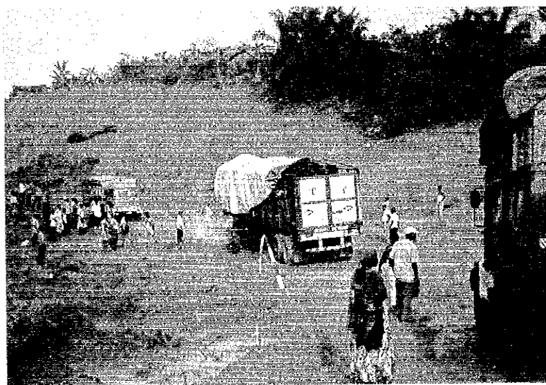
調査地域内の風景 (ダנקワ〜ウイワソ間 工事中の道路)
