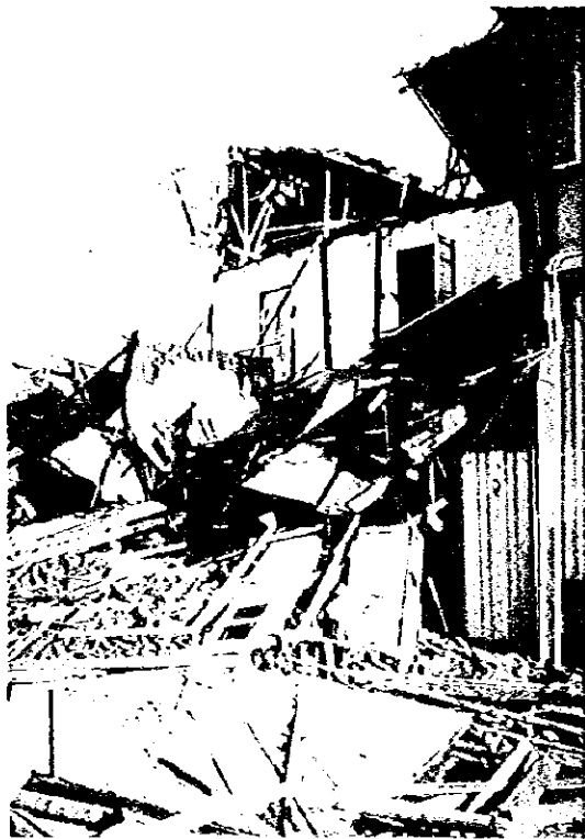
写真2 アルメニア市内被災状況
