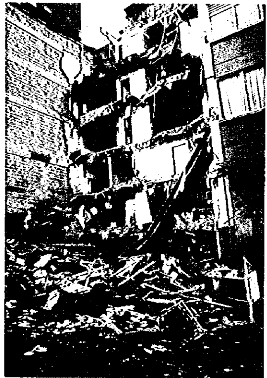
写真3 アルメニア市内被災状況
