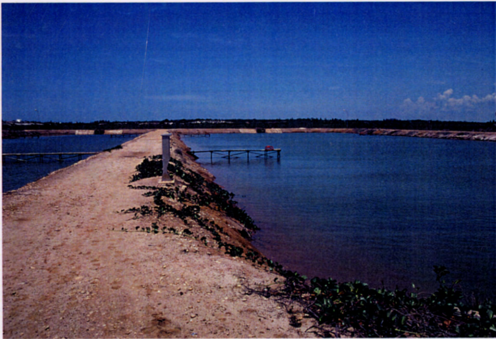
アンツァニビンゴ・エビ養殖訓練センター エビ養殖池 潮の干満を利用して池中の水を交換している
