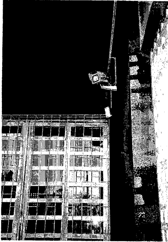
写真-4 監視カメラの設置状況
