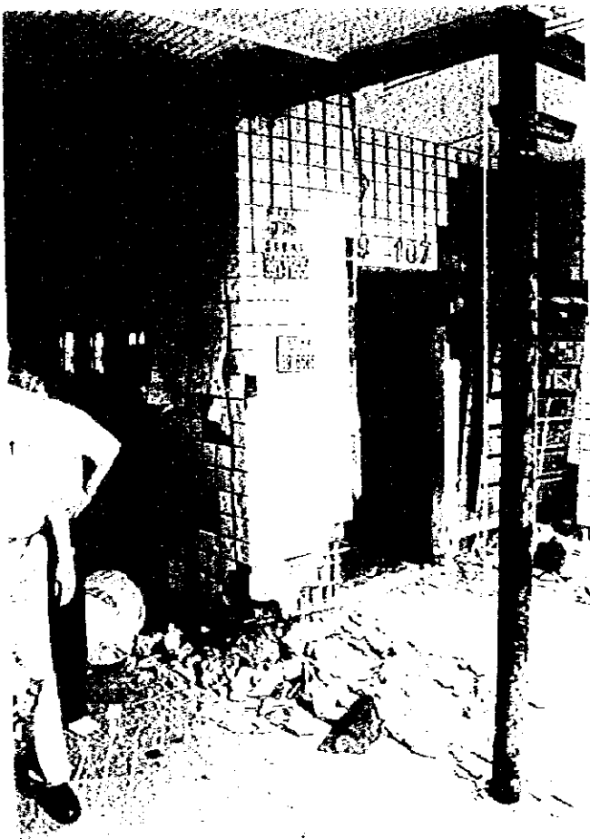
10 天下一家ビル 柱脚コンクリートの剥落。フープの破断が見られる
