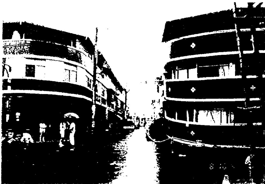
19 プーリ市内 同様の建築物の明暗
