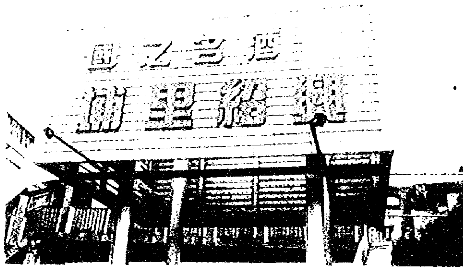
20 詔興酒工場 製造工場1棟が崩壊
