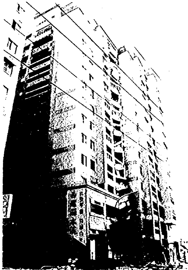
2 徳昌マンション 16階建て。桁行き方向は1スパンごとに雁行している
