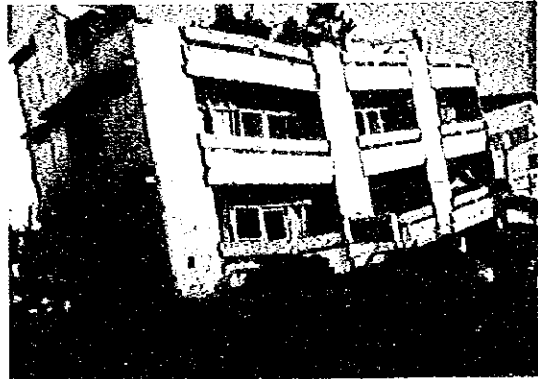
写真 64 倒壊建物(角地に建ち、1階が欠けた) 撮影場所: 台中縣東勢鎮 撮影日: 1999.9.29
