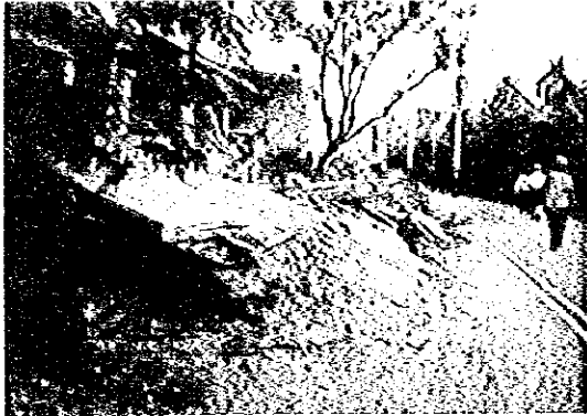
写真 19 断層隆起により道路に乗り上げた建物 撮影場所: 台中市北東の大坑川の南 撮影日: 1999.9.28
