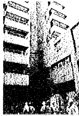
写真 50 「徳川家康」の4階柱の主筋座屈 撮影場所: 台中縣豐原市南陽路 撮影日: 1999.9.29
