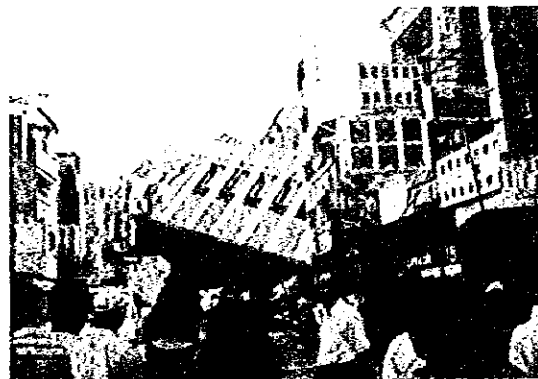
写真 66 倒壊建物「東勢王朝大樓」(倒壊2日後) 撮影場所: 台中縣東勢鎮 撮影日: 1999.9.29
