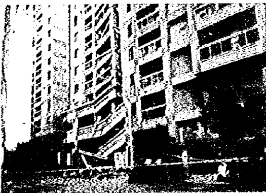
写真 5 1階が崩壊した建物「興大生活」 撮影場所: 台中市南區五權南路 撮影日: 1999.9.28
