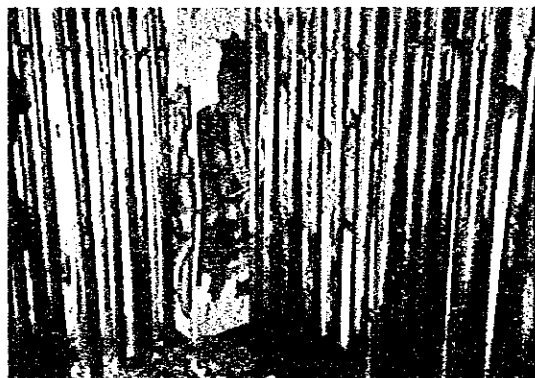
写真 51 「徳川家康」の4階柱主筋の詳細 撮影場所: 台中縣豐原市南陽路 撮影日: 1999.9.29
