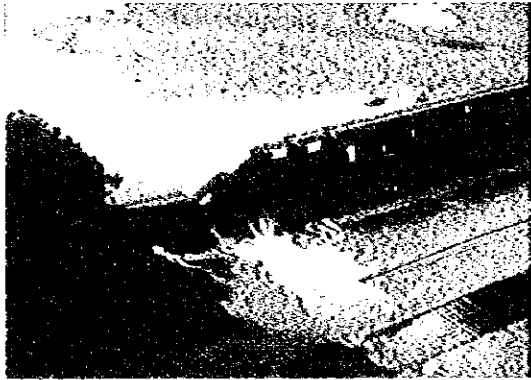
写真 25 ダムの2門崩壊 撮影場所: 台中縣大甲溪の石岡壩 撮影日: 1999.9.29
