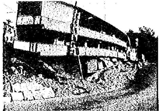
写真 56 断層上で倒壊した建物「雙原獅子會館」 撮影場所: 台中縣豐原市 撮影日: 1999.9.29
