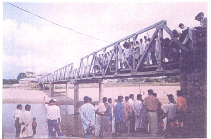
完成橋梁 (平成6~8年度地方道路簡易橋建設計画) 橋梁番号：01-02-01
