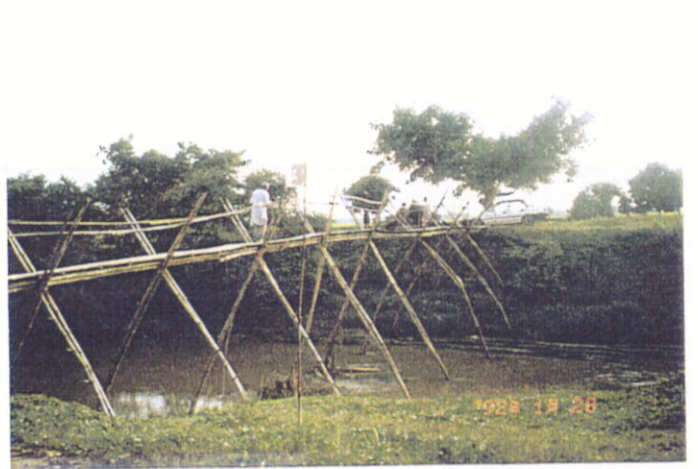
現橋は竹を組んで作られた仮橋 橋梁番号：04-00-01
