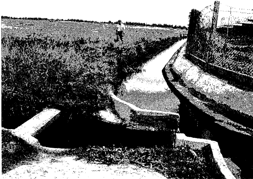
同上 幹線水路と分水工
