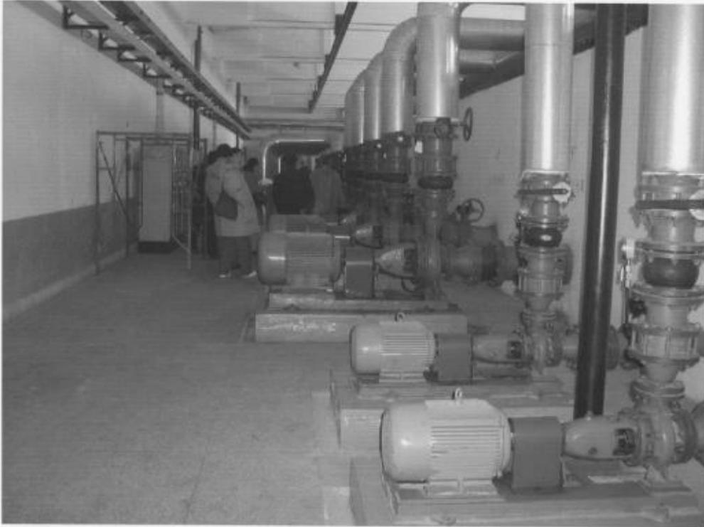
写真5-4-1 冷却水用SI型ポンプ設置状況
