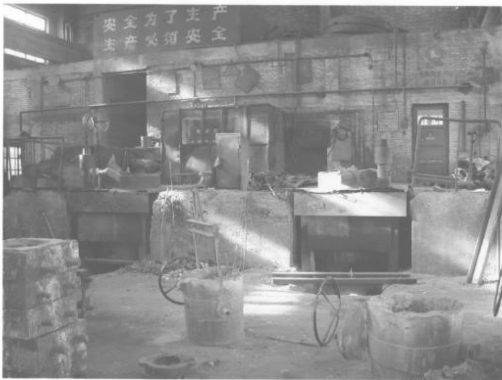
写真 2-2-4 小物部品鑄鋼工場の中周波炉
