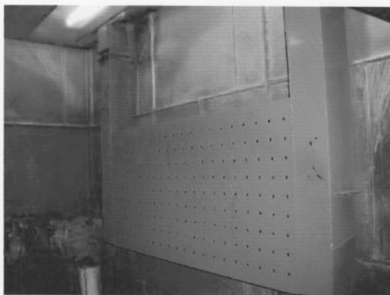
写真3-9-1 吹きつけ塗装ブースの排気改善
