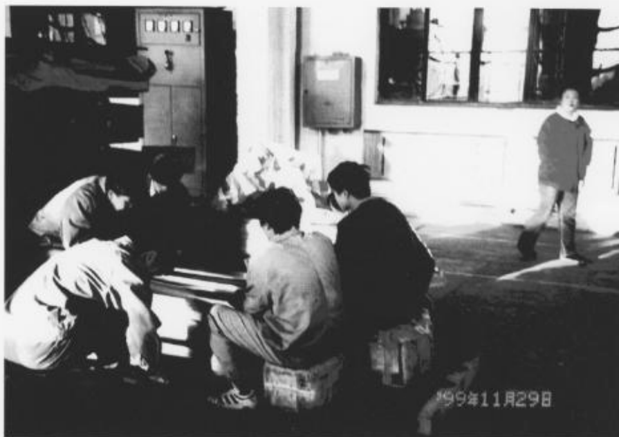
写真2-2-2 錆落とし作業
