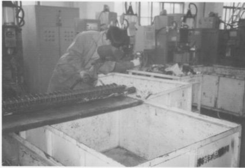
写真2-5-1 プロジェクション溶接後の補助アーク溶接 ペダルプレートのプロジェクション溶接後に、並べて全数アーク 溶接で補強を行なっている。
