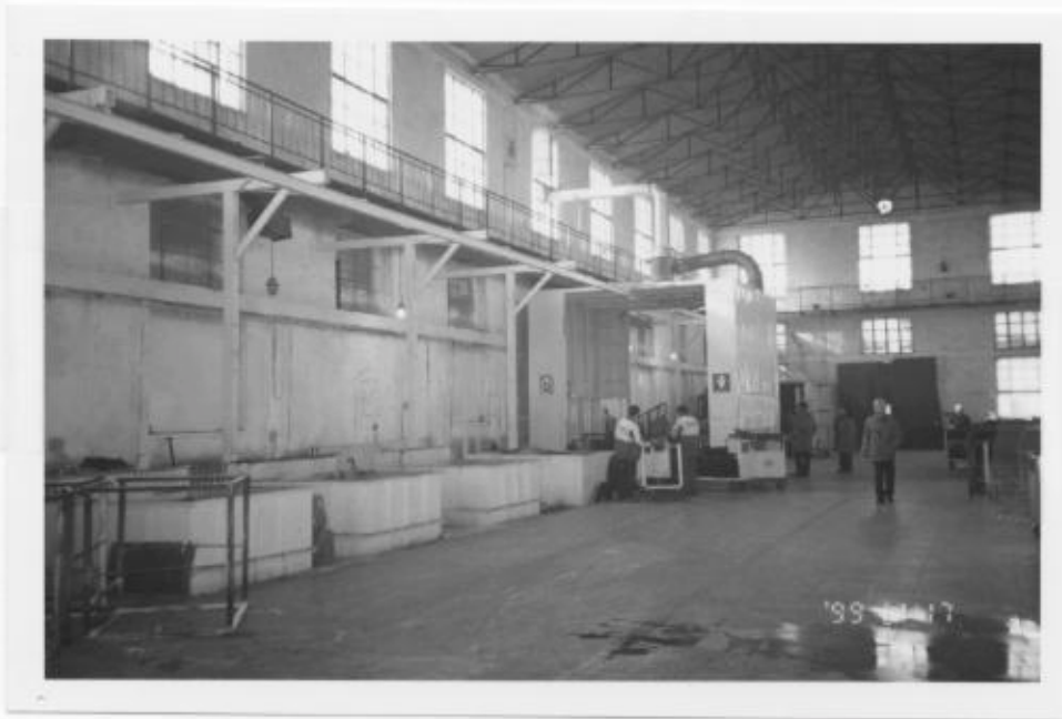
写真・3-2-11 塗装工場の全景
