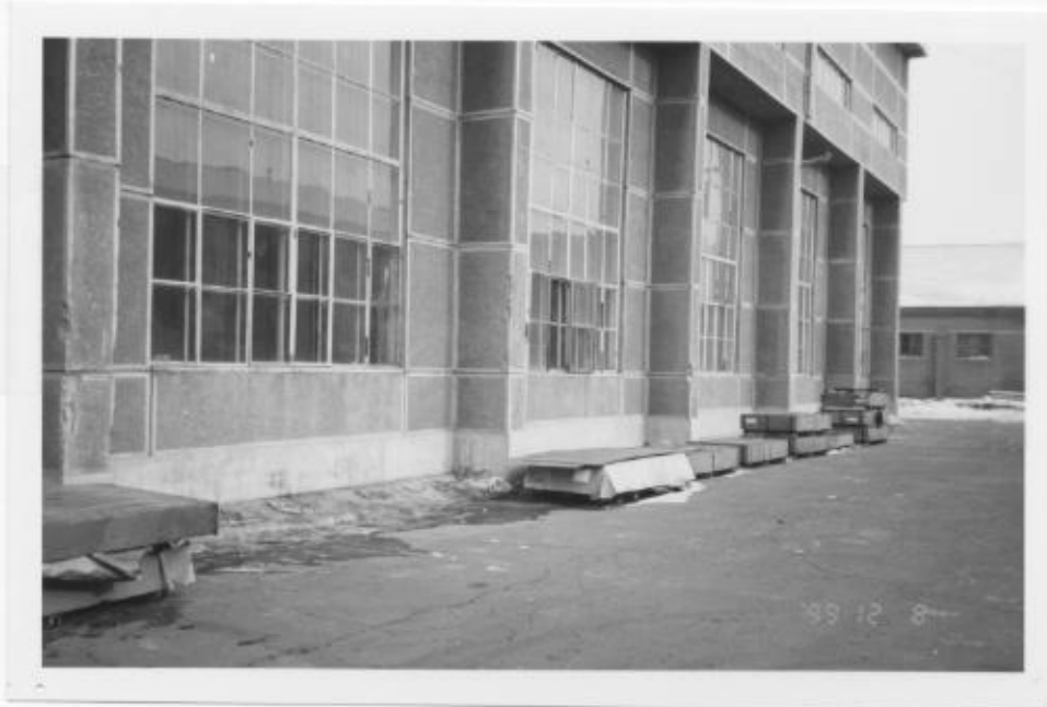
写真3-3-1 鋼材の屋外保管状況(1)
