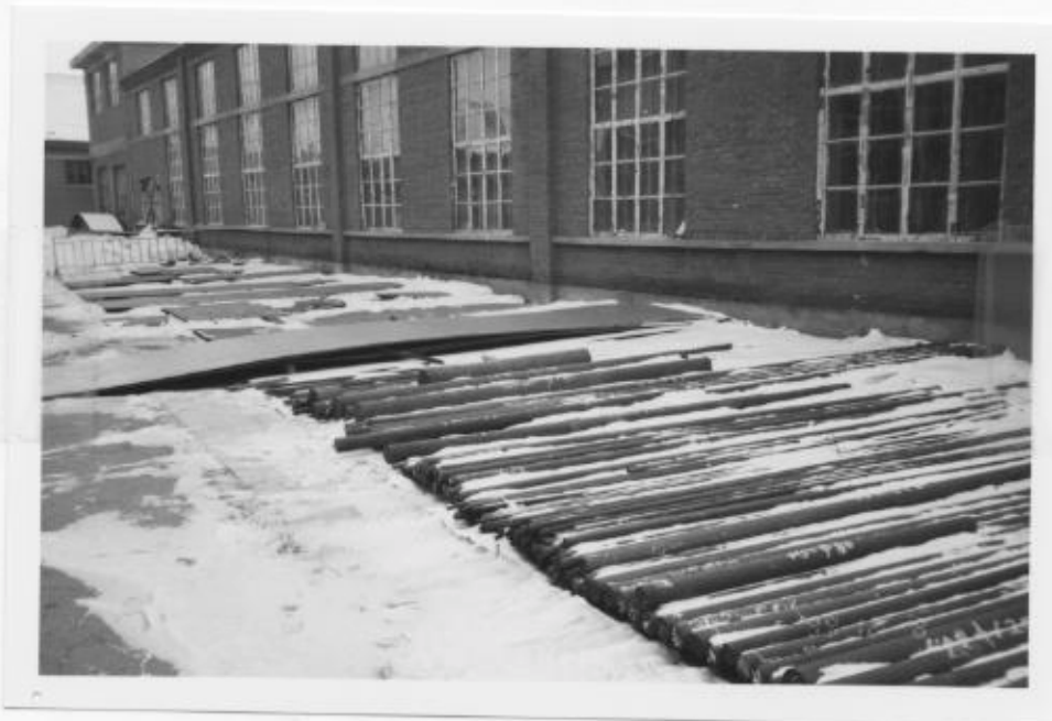
写真3-3-2 鋼材の屋外保管状況(2)
