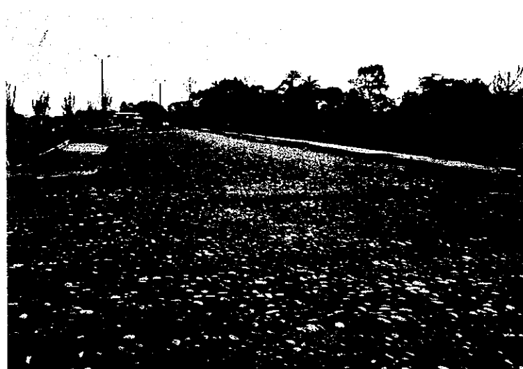
マーカス市内の道路 現地発生材の玉石による舗装
