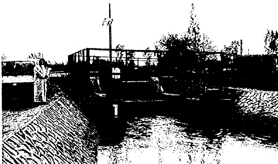
Branch canal 始点に設置された下流制御ゲート (改修例)
