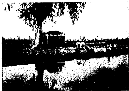
写真 2-3 Branch canal からメスカ水路への取水地点（ポンプ）
