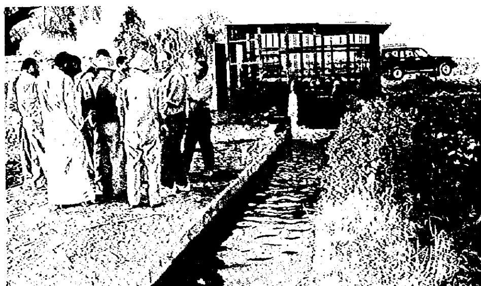
メスカ開水路への揚水状況 (改修例)
