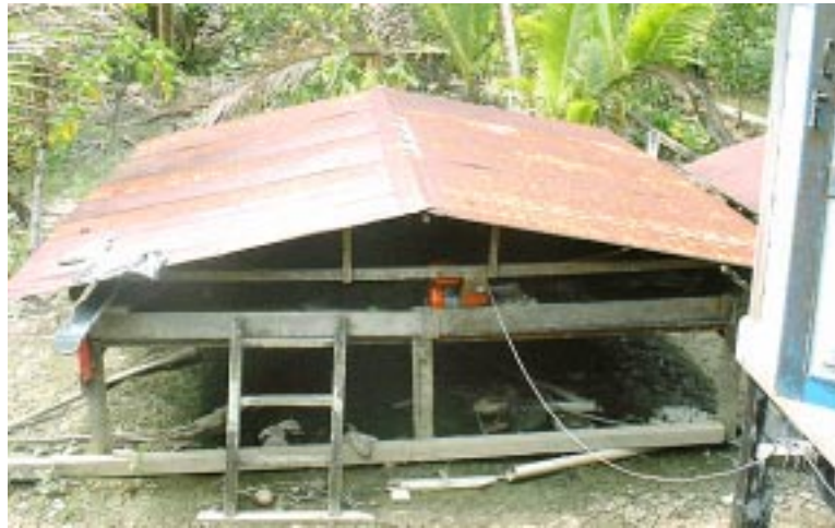
副村長宅の自家用ディーゼル発電機 1.5kVA( 推定 )
