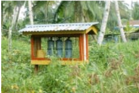
消火器スタンド
