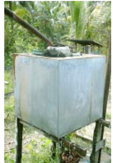
屋根からの雨水タンク
