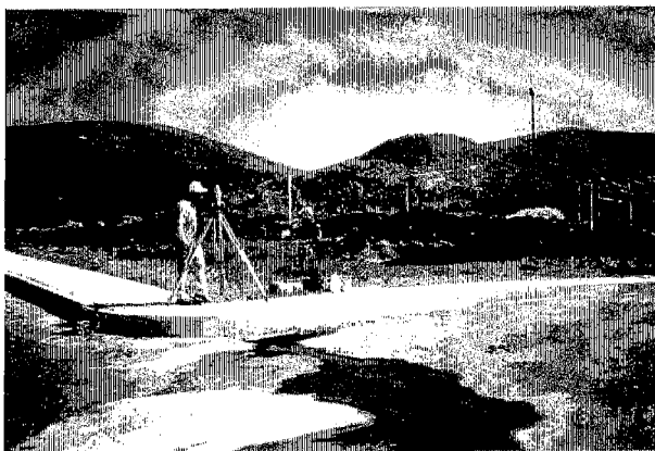
No.1 プラント予定用地の測量 (1995年11月)
