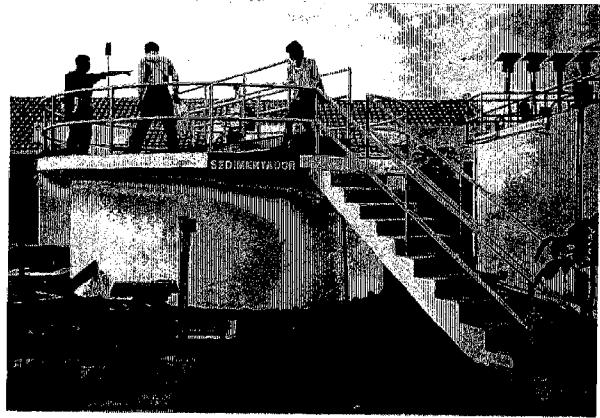
No.45 沈殿槽全景 (右端にばっ気槽の側面が見えている)
