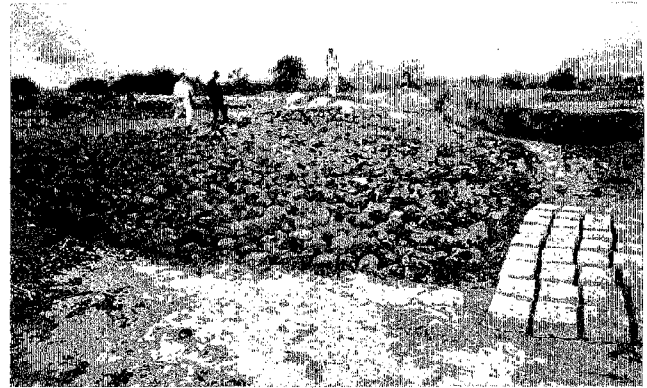
緑資源公団の実証調査地区のため池の余水吐
