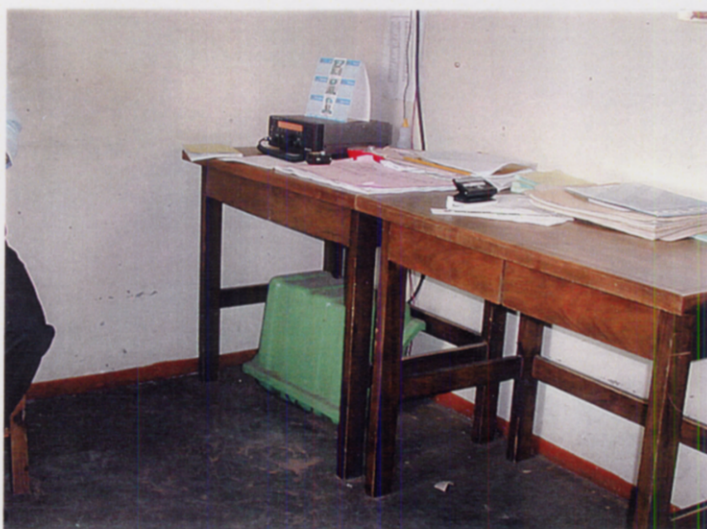
写真18 Tsetseng村 (村役場内のPVを電源とした無線設備)
