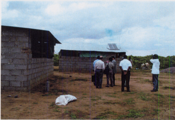
写真13 養鶏施設 (R I I C融資対象施設) (P Vパネル)
