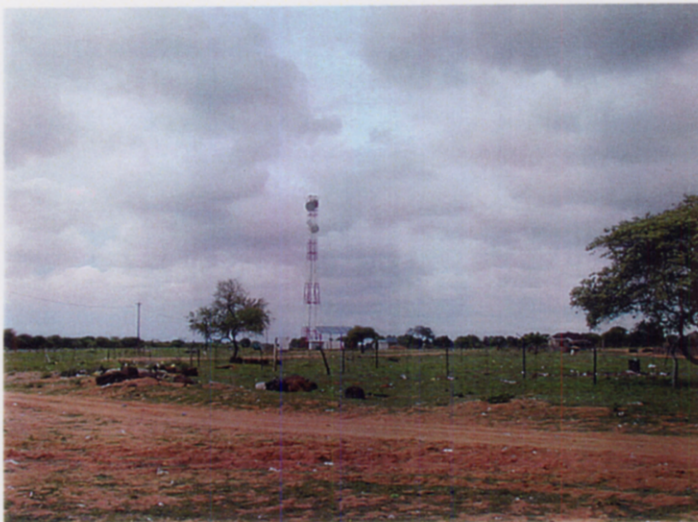
写真2 PVを電源とした電話 中継施設 (Sekoma)
