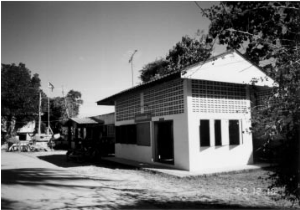
ガ才市役所執務室
