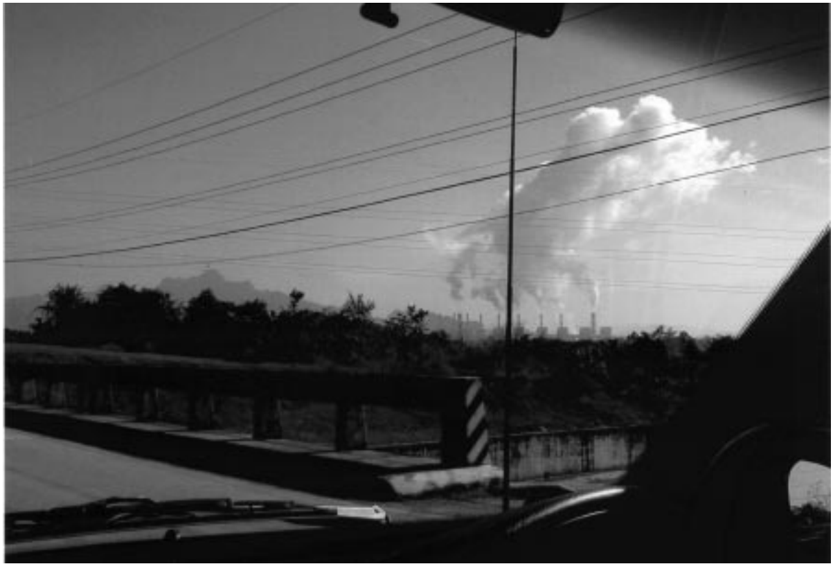
Mae Moh石炭火力發電所進入路
