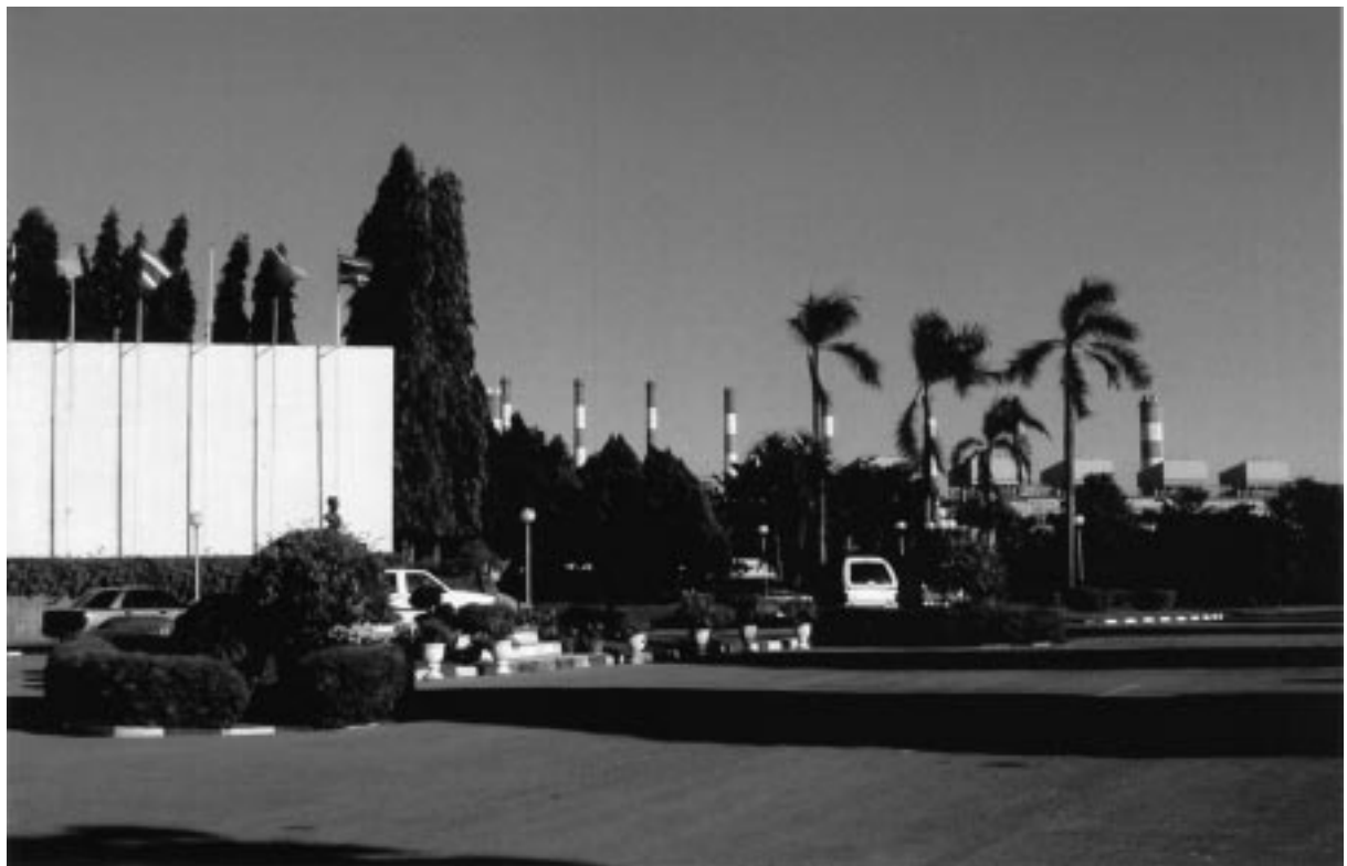
Mae Moh石炭火力發電所
