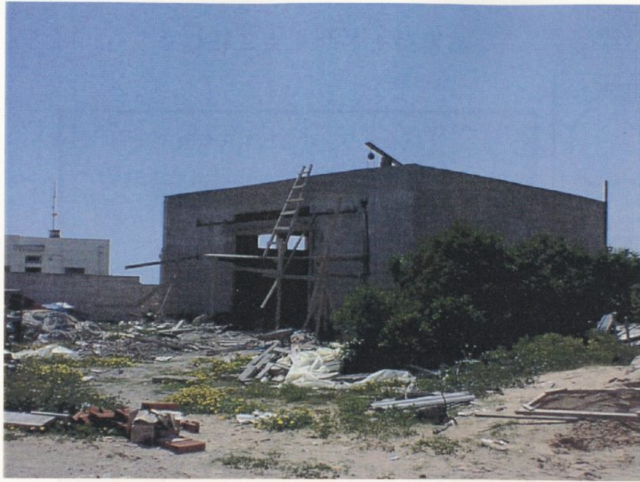
建設中の機関実習棟
