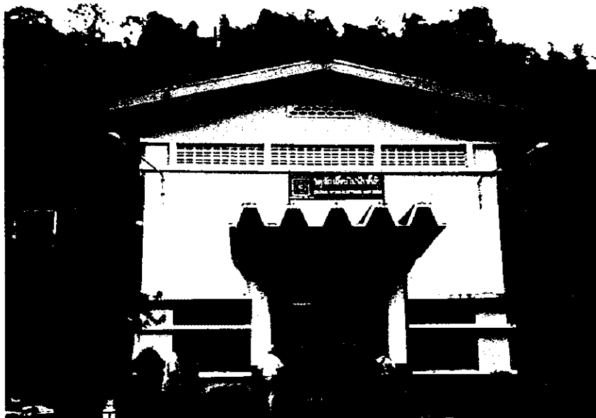
Nam Dong 発電所
