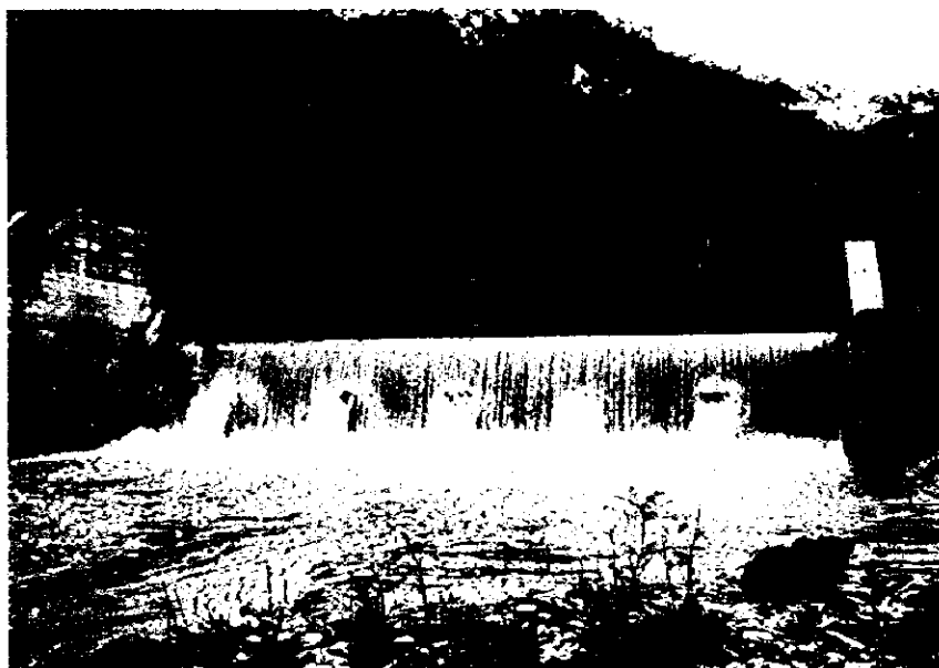
Nam Pa 発電所用ダム 灌漑用と合わせて取水、写真左側が取水口
