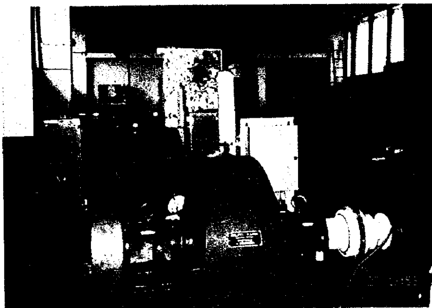
Nam Dong 発電所 水車発電機 1008kW (336kW×3台)、フランス製横軸ベルトン水車、同期発電機 1995年設備改修を実施
