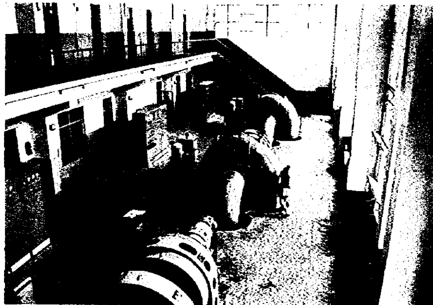
Seti 発電所 水車発電機
