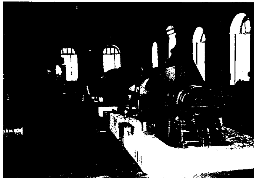
Sundarijal 発電所 水車発電機 600kW (300kW×2 台)、イギリス製横軸ベルトン水車、同期発電機 1966 年部分改修を実施
