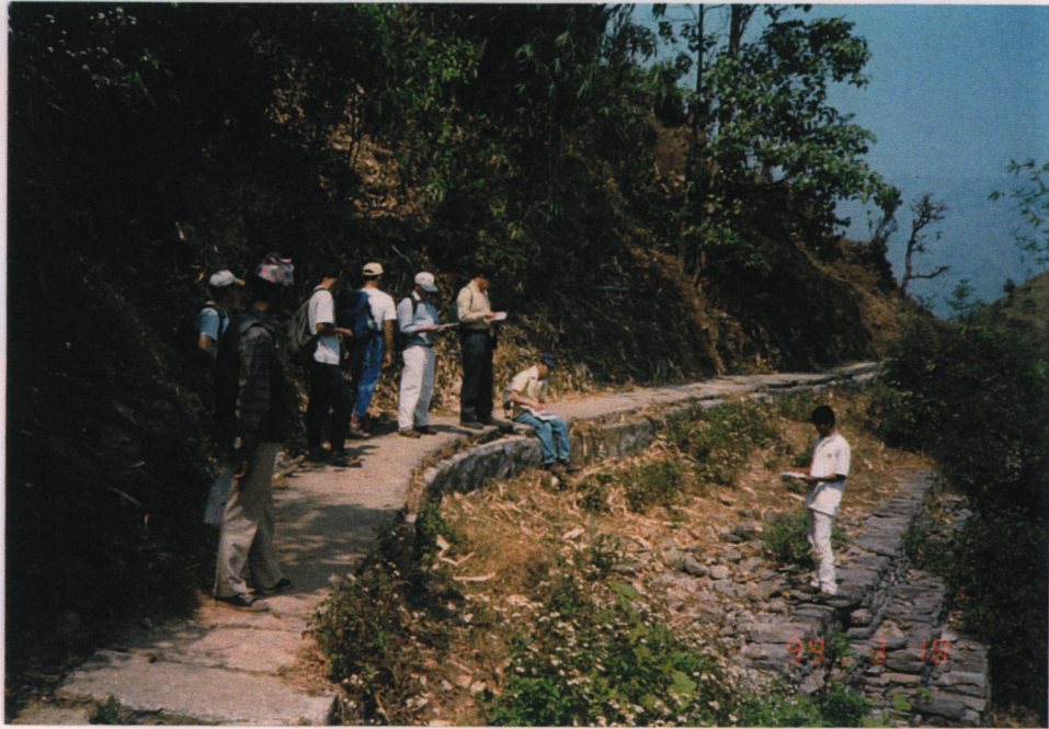
＜サブプロジェクト（地滑り防止工事）の視察＞ NGO 職員（右）が活躍
