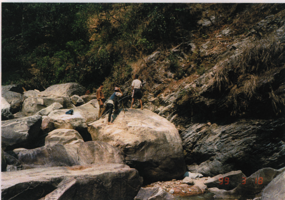
<河川から畑に水を引くため灌漑用水路を住民が建設中>
