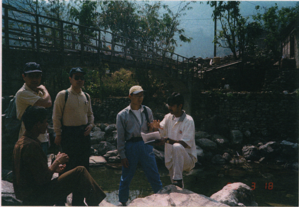
<サブプロジェクト（護岸工事）の視察> 団員がネパール NGO 職員（中央白服）から説明を受ける
