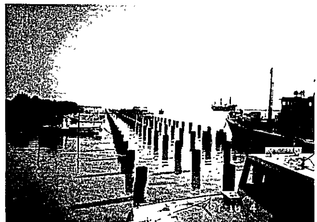
モングラ港。下流に向かって建設が中止されたジェッティーと沖待ちのコンベンショナル船を望む。この地点より下流部に向け、延長10kmの水深4.5～5.5mの地点があり、本年より2000/01にかけて4年間で3.6百万㎡の浚渫を行う予定であり、11月に入札を行う。
