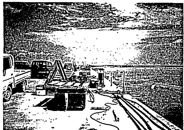
建設が進むジャムナ架橋。橋長は4.8kmで4車線の道路と鉄道の併用橋。10月9日マイルストーン会議において、アクセス鉄道に関しては、当初mゲージであったものを、広軌も利用できる3線方式に変更する決定が行われた。
