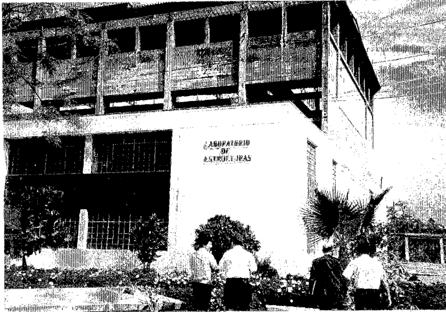
構造実験棟 (建物上部の開口部には、 窓が設けられていないため 砂埃などの対策を検討中)
