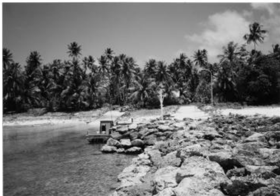
資料写真-34 アルノ環礁 イネ漁業基地 岸壁施設
