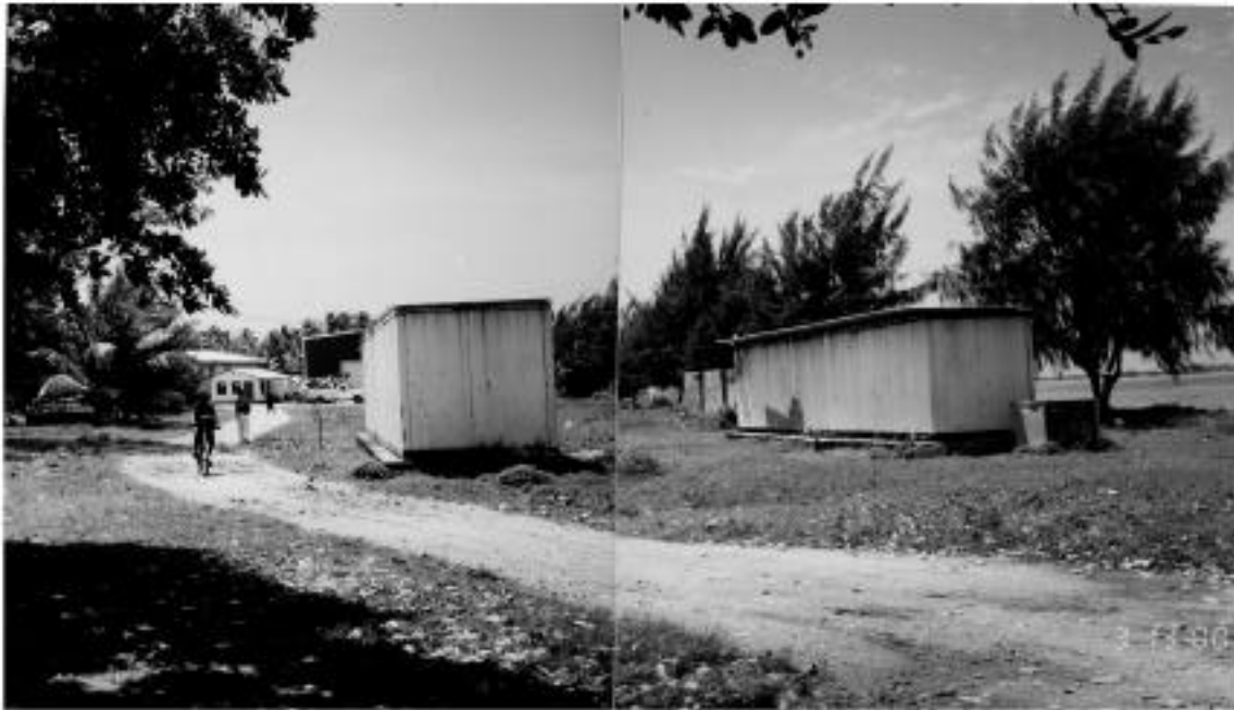
資料写真-10 計画サイト (使用されていない コンテナ/撤去予定)
