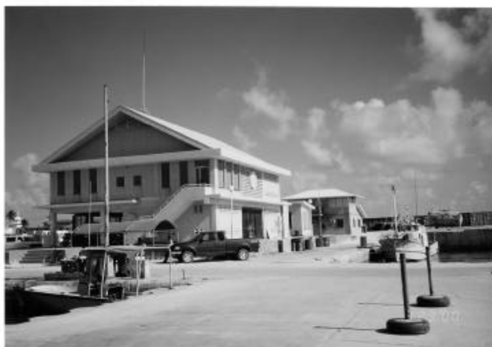
資料写真-38 (同上) クワジェリン 魚販売センター (手前の2階建て建物)
