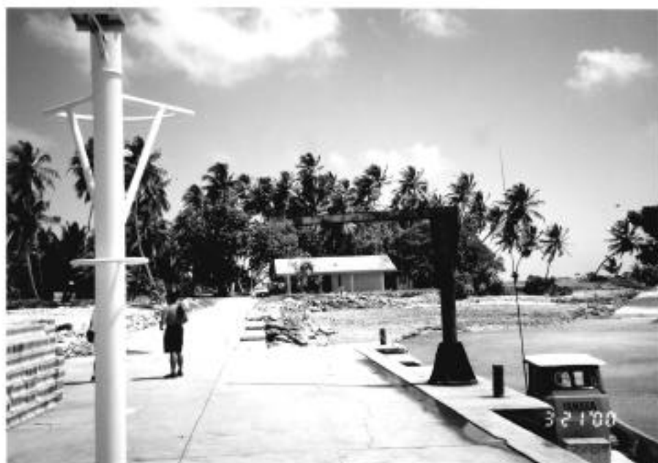
資料写真-31 アルノ環礁 アルノ漁業基地 岸壁施設
