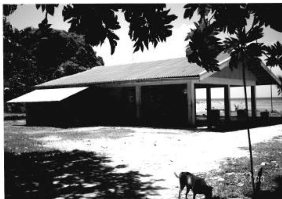
資料写真-32 (同上) アルノ漁業基地 事務所・冷蔵庫 製氷機施設
