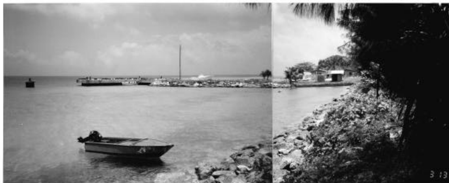
資料写真-15 サイト前護岸から棧橋を望む
