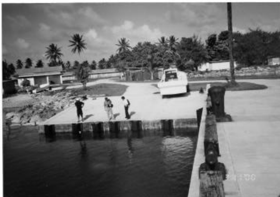
資料写真-17 棧橋脇（北側）の斜路 自航式バージ船が荷役 を行う。（防舷材はない） 運搬船、漁船の接岸と 荷物の揚げ降ろしも 可能と思われる。
