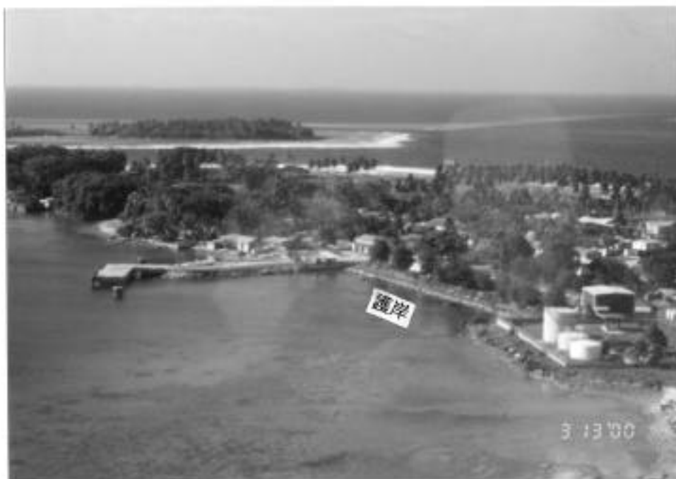
資料写真-4 ジャルート環礁 ジャポール地区 左：棧橋 中央：計画サイト 右：Mobil 給油タンク
