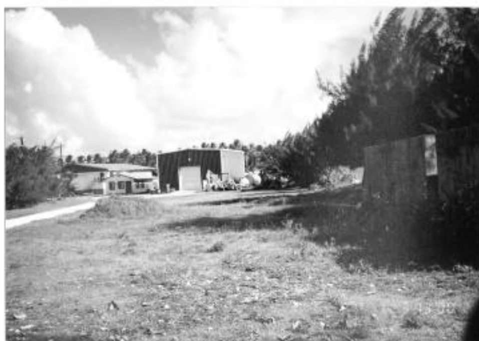
資料写真-9 計画サイト 奥は MEC の発電所施設 手前右から： 倉庫、事務所、発電所
