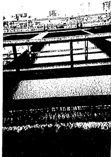
写真-10 油水分離槽からの処理水
