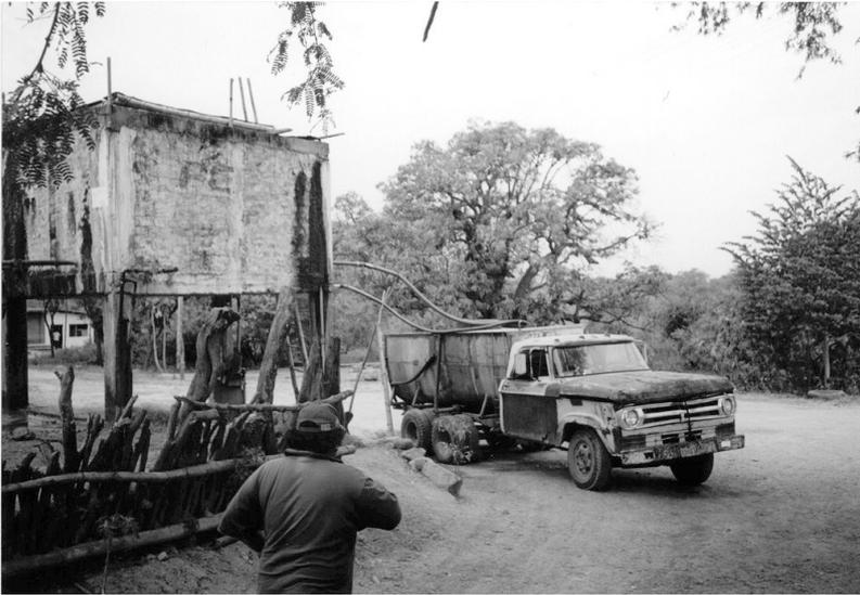
公共機関の給水車が配置されていない所では、民間の給水車が運用されている。タンク等が老朽化して衛生的ではない。
