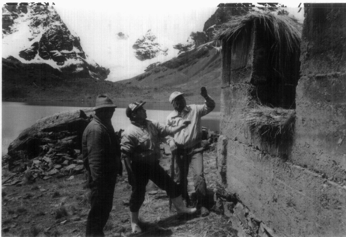
コンドリリ及びチアルコタ小湖沼群地区 倉庫、簡易加工処理施設の建設（1997年1月）
