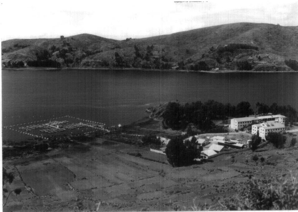
CIDPA (アルテイ プラーノ水産開発セン ター) 全景
