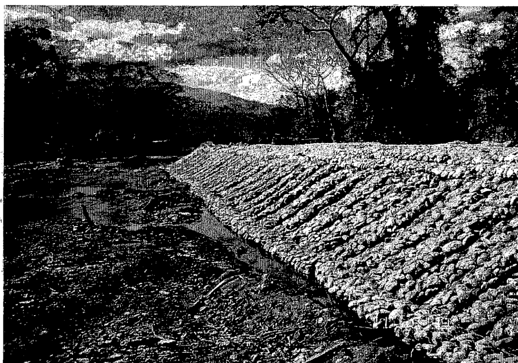
研修後全景（下流側から）：堤防法面を保護している蛇籠
