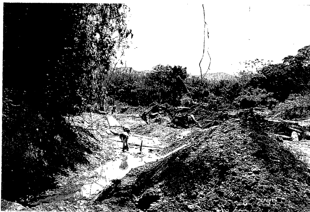
水路研修：基礎地盤の整地作業中
