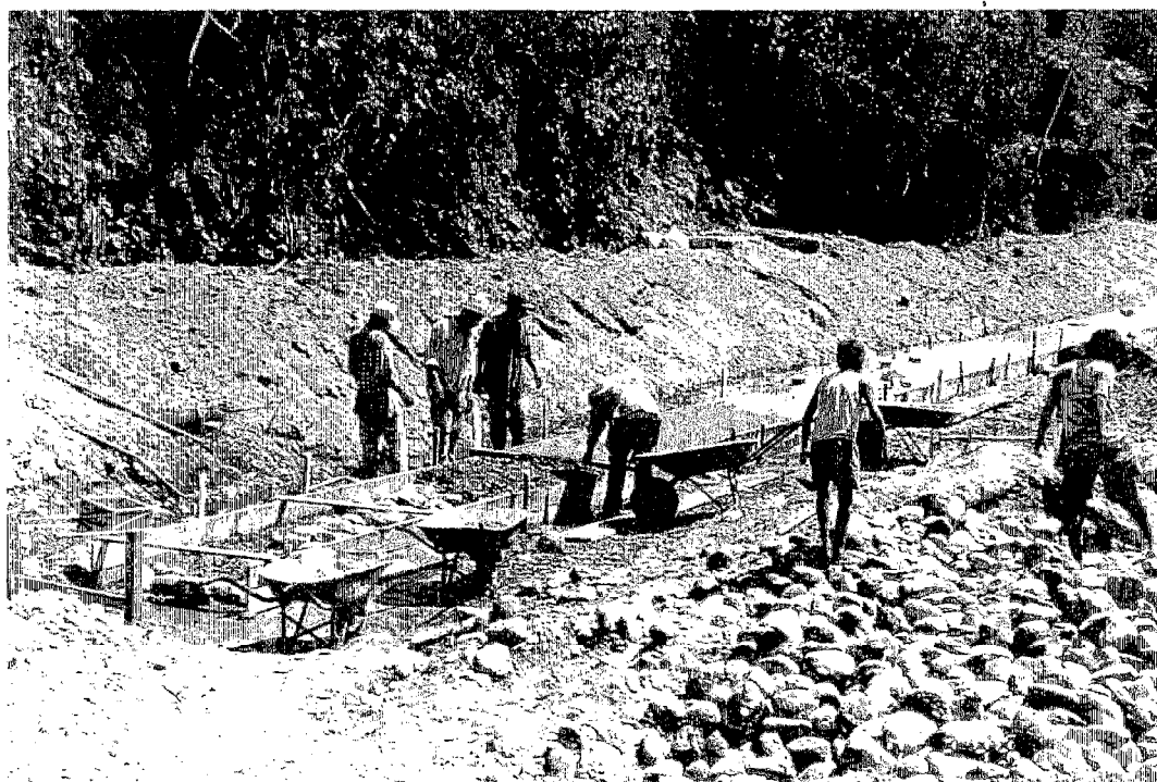
水路研修：すべて人力で定版を打設中
