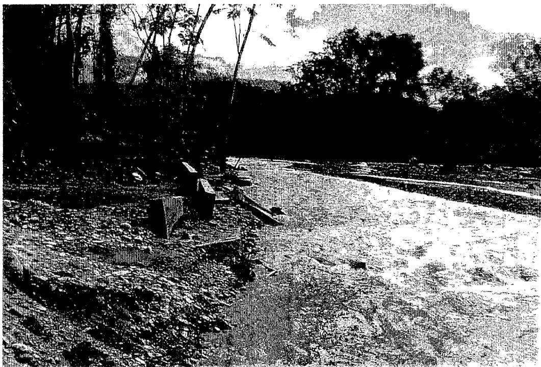
研修前現況（下流側から）：破壊された水路と濁流
