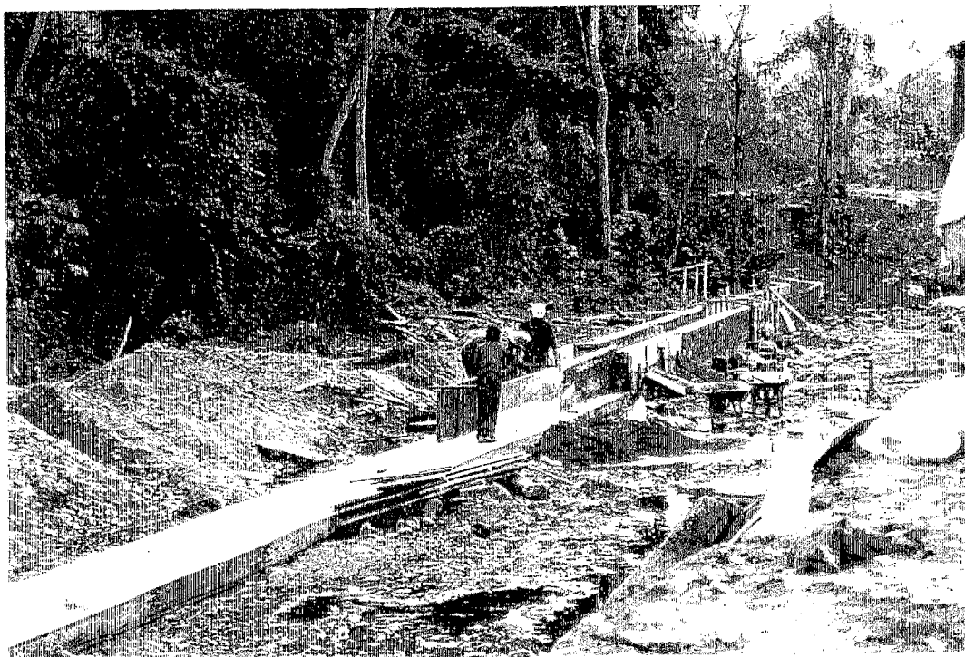
水路研修：壁部の型枠を設置
