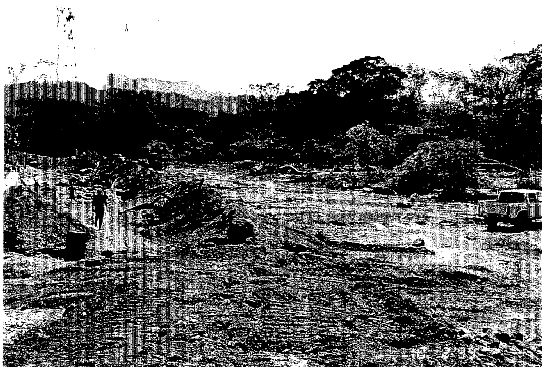
研修前現況（全景：下流側から）：別件工事で簡易堤防を築立中
