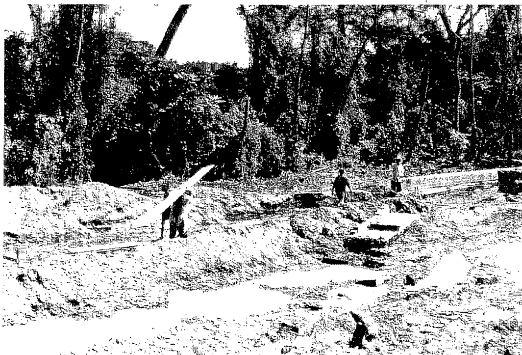
水路研修：底版打設のため型枠用の板を搬入中
