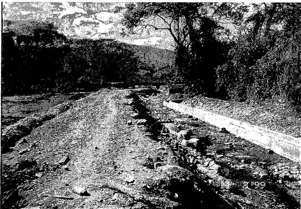
研修後（上流側から）：受益農家により復旧された水路
