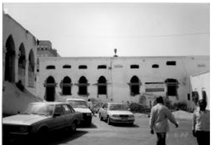
8. ムカッラ母子病院 建設中の小児科
