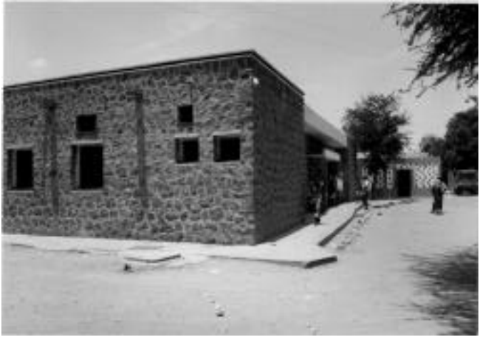
22. トゥール・アル・バハ郡病院 病院正面
