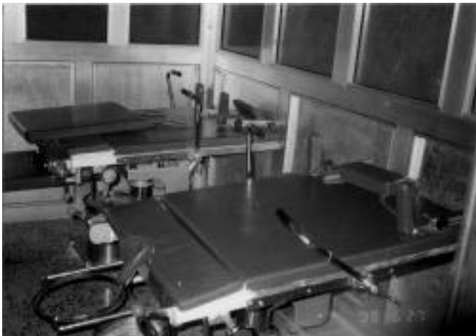
5. アル・サウラ州病院 旧分娩室（廊下を仕切って使用している部屋）
