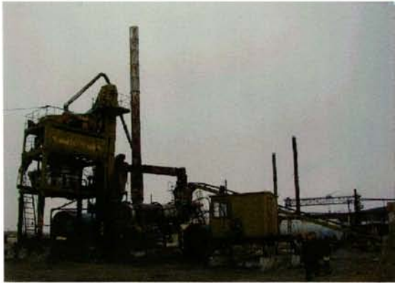
ロシア製アスファルトプラント (50ト/時間) この他 25ト/時間の As プラントが併設されている。
