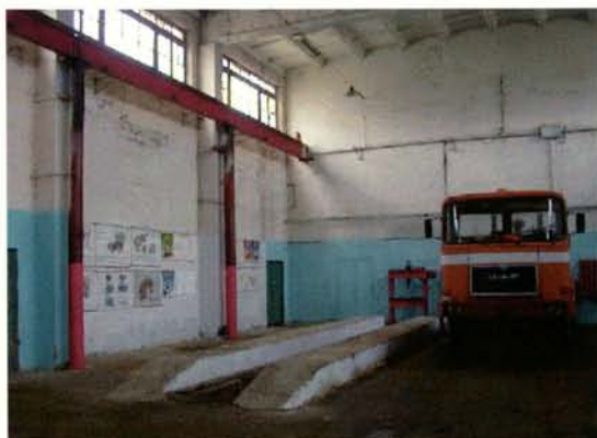
場内の機材修理用ピット、工具類は扉の中にある。
