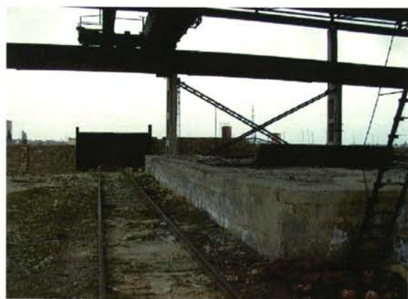
鉄道の引き込み
