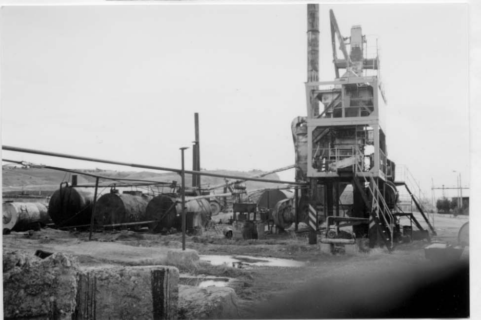
トビリシ No,11 ワークショップ 近郊のアスファルトプラント (稼動中)
