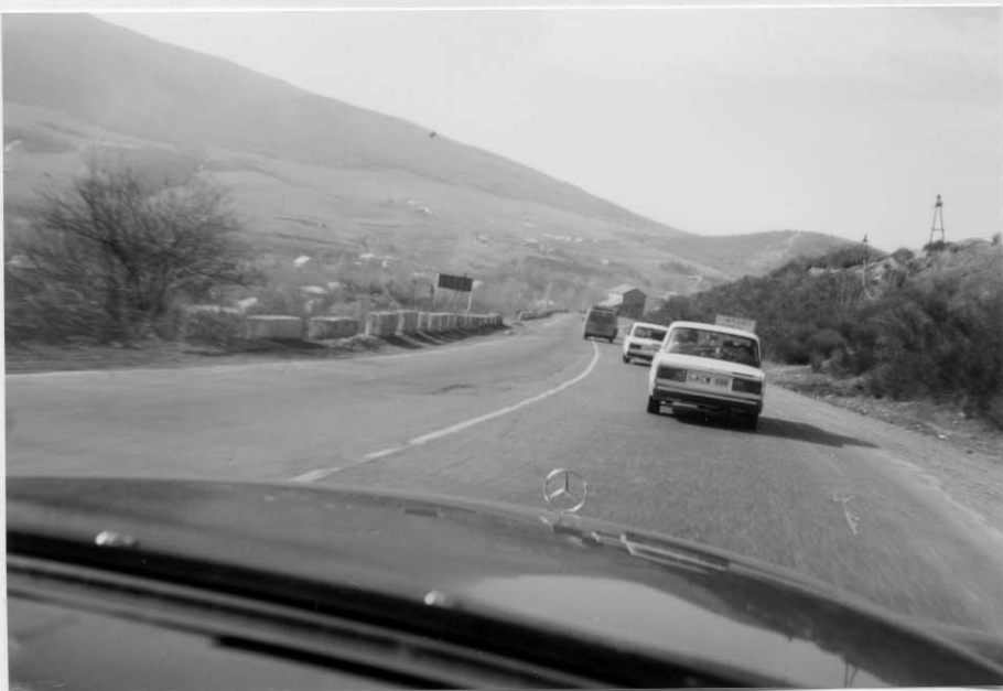
10年前の旧ソ連時代に作った道路 老朽化の為表層に多くのピンホール が入っている。ゴリ市西 5km
