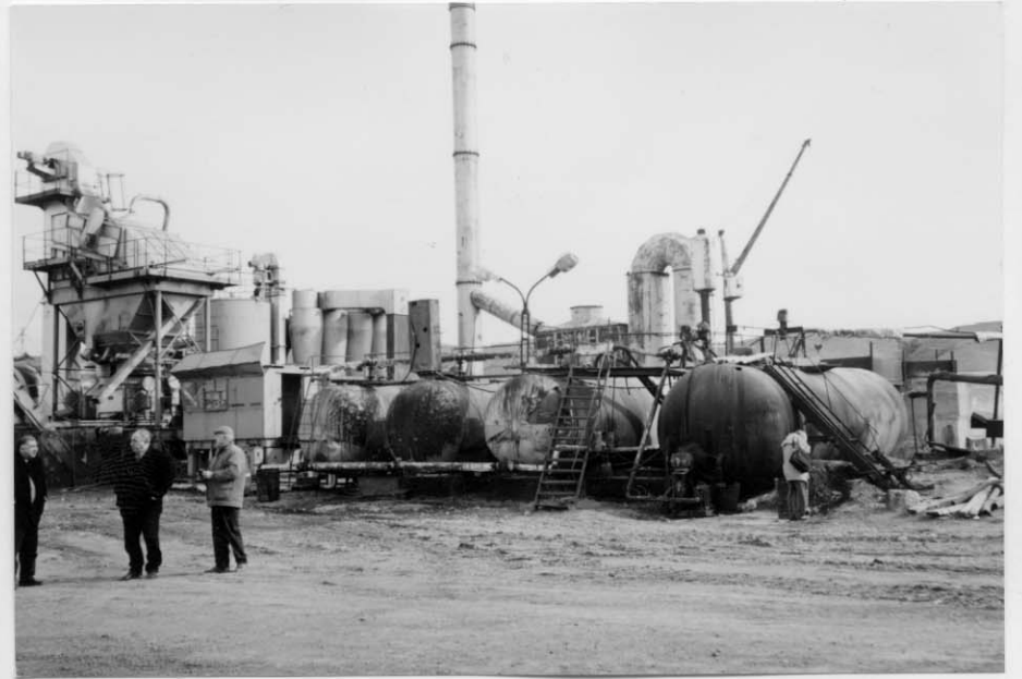
ハシュリ No,5 ワークショップ 近郊のアスファルトプラント (稼動中)
