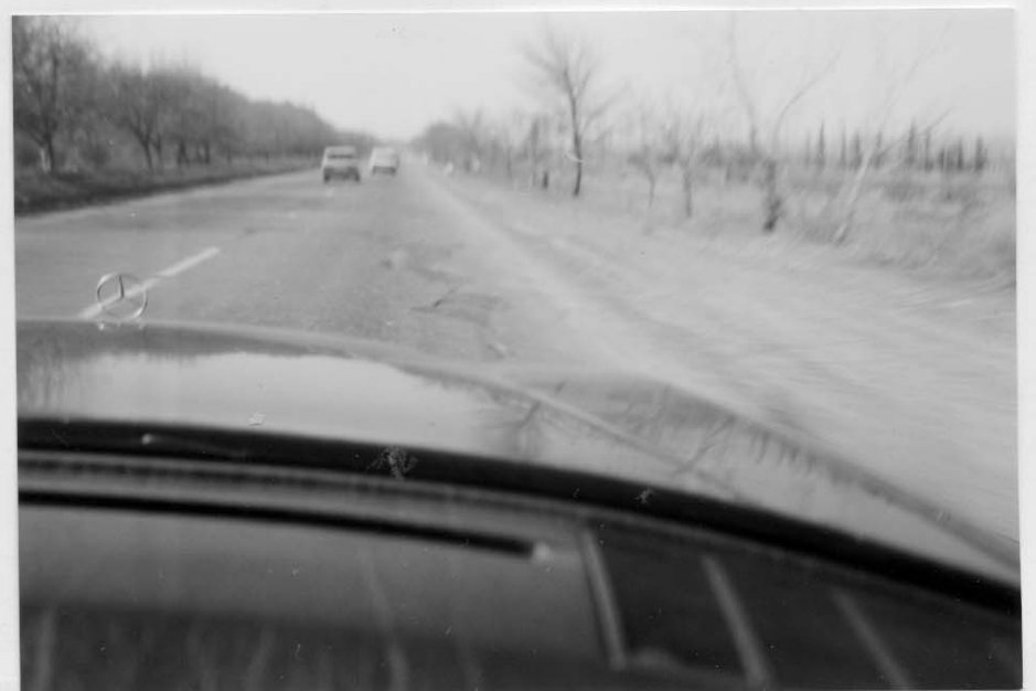
部分補修した後も一部に傷みが 発生している。トビリシ市西方 15km
