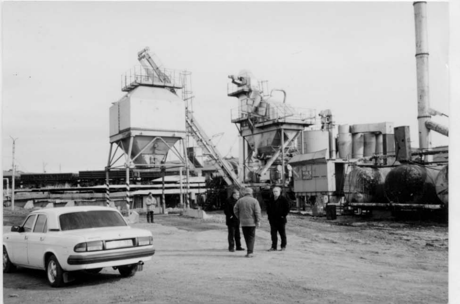
ゴリ No,3 ワークショップ近郊 のアスファルトプラント (稼動中)
