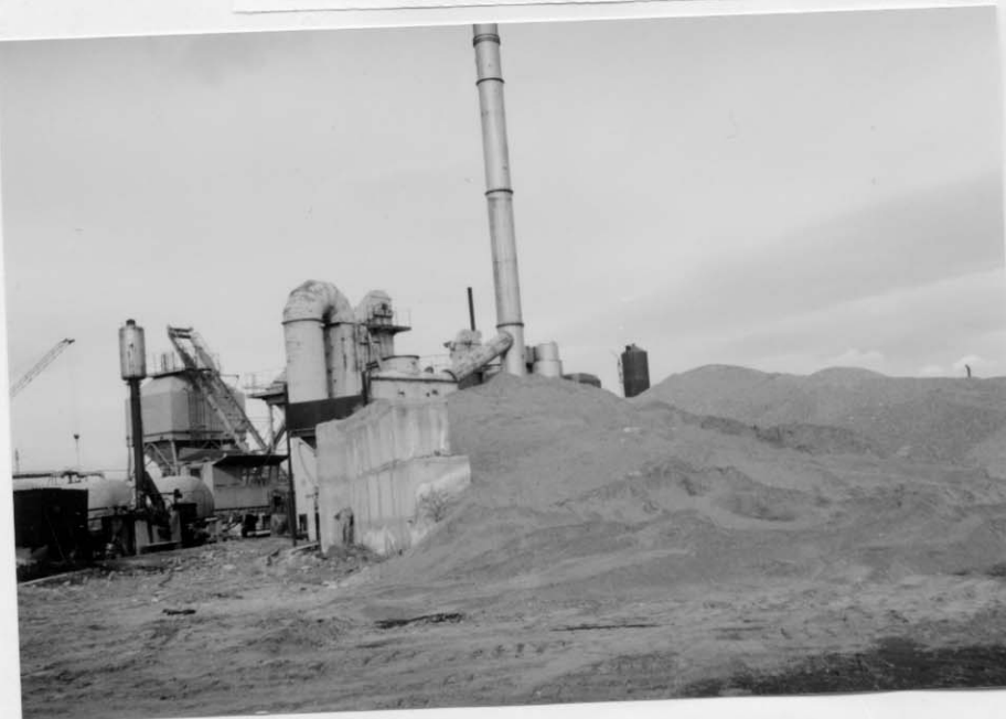
トビリシ No,11 ワークショップ 近郊の砕石プラント (稼動中)
