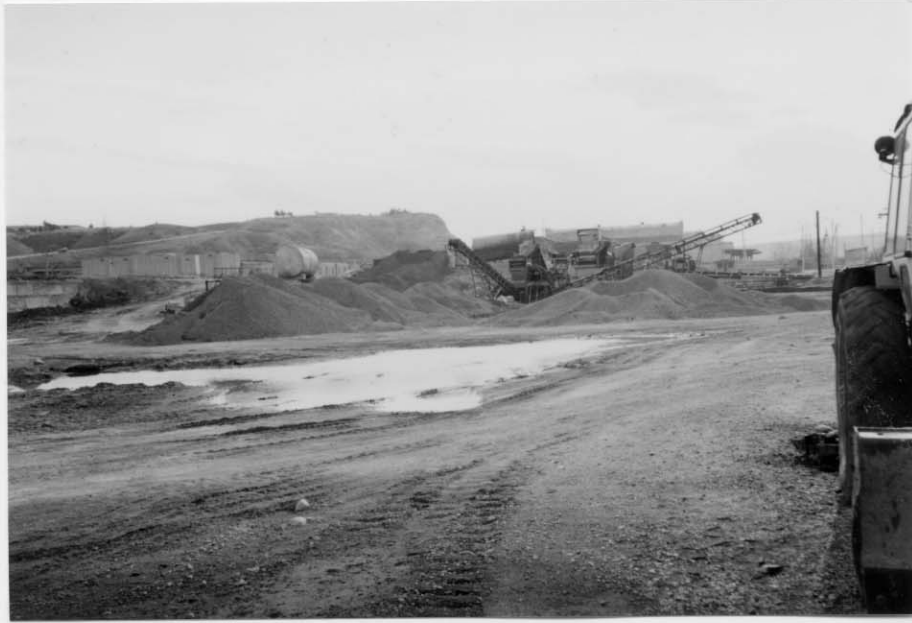
ハシュリ No,5 ワークショップ 近郊の砕石プラント (稼動中)
