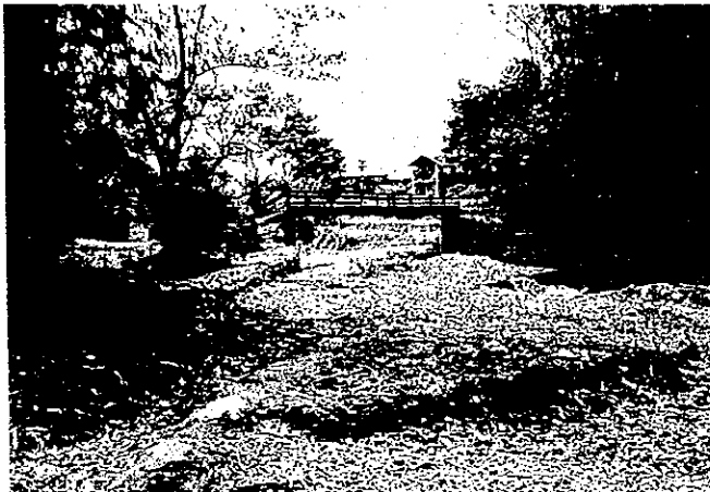
グワング川支流②渡河地点(本線下流側)
