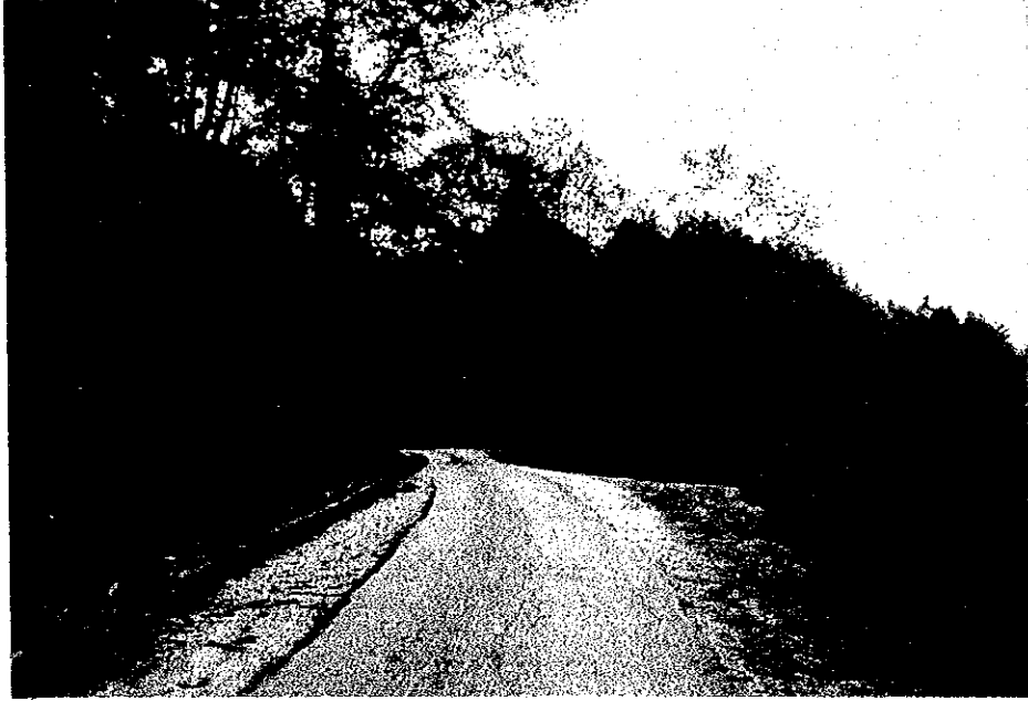
写真 3.4.1 ジリ道路の道路現況
